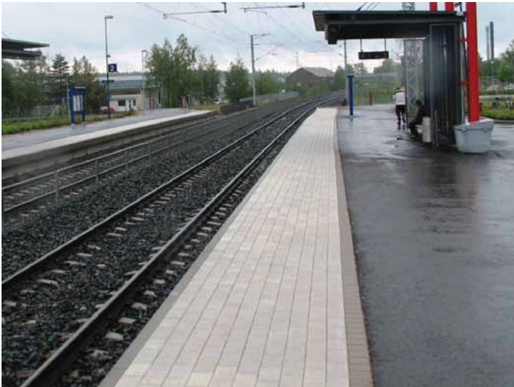
Kuva 17. 550 mm korkea reunalaituri (kuva Masala). Laiturin vaara-alue on merkitty värierolla ja tuntoon perustuvalla merkinnällä. Kuvan laiturilta puuttuu RATO:n mukainen keltainen varoitusviiva vaara-alueen reunalta.
