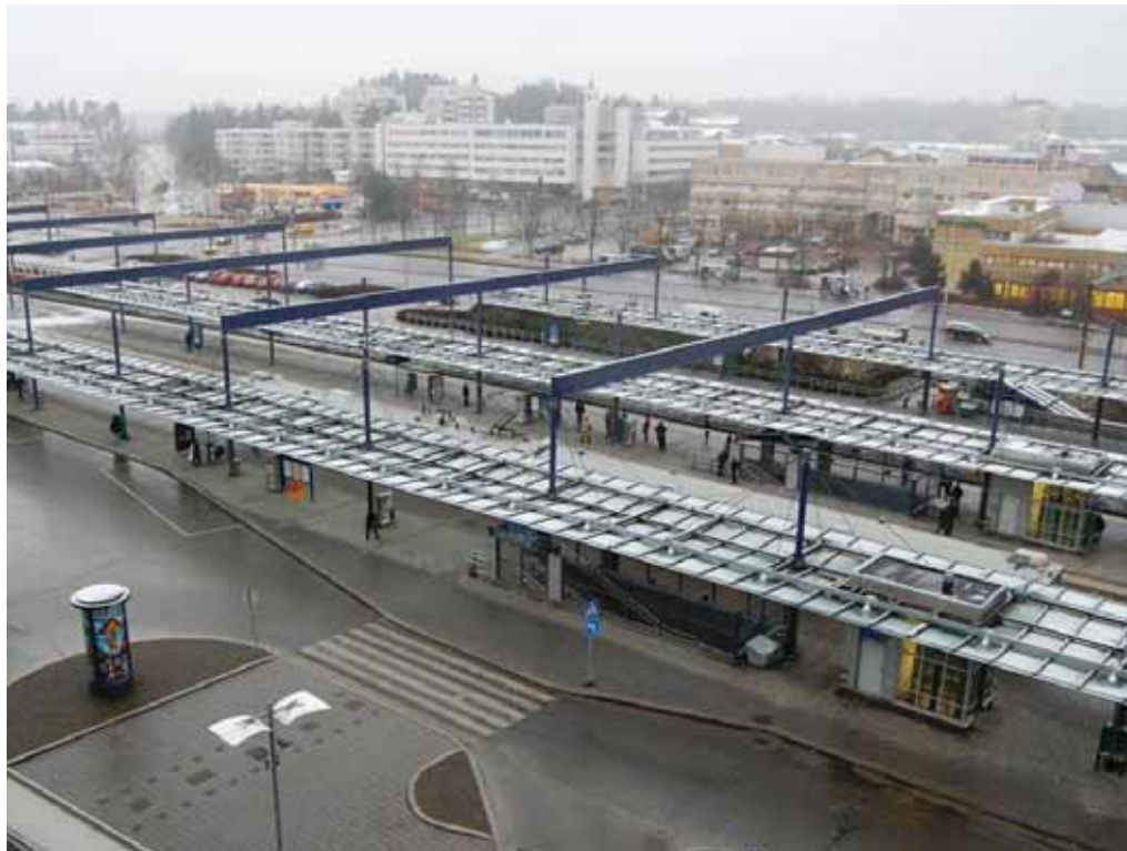
Kuva 19. Laiturikatoksen tulisi kattaa valtaosa asemalle pysähtyneen junan pituudesta kauko ja lähi 1 -luokissa. (kuva Leppävaara).
