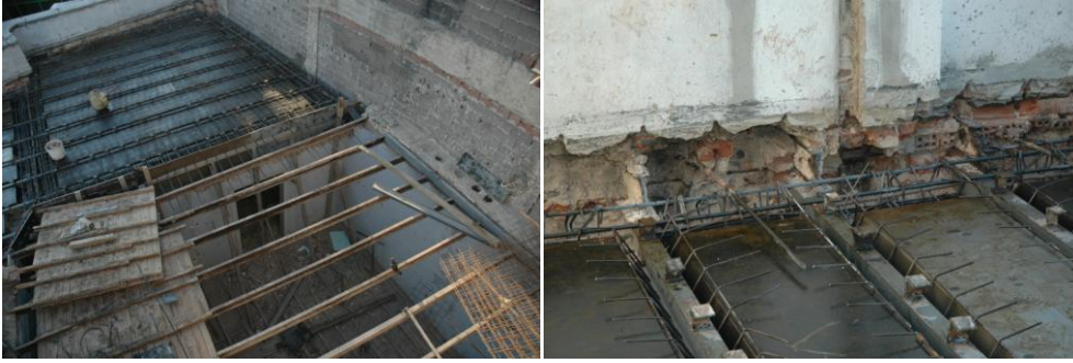
Şekil 5.10 : Kaldırılan ve yeniden yapılan volta döşemelerin olduğu kısım (Fotoğraflar: Y.M.A).
