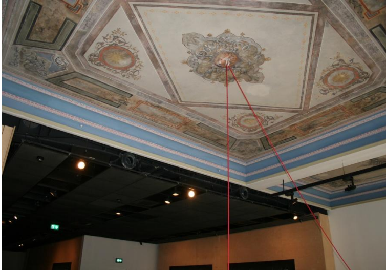
Şekil 5.33 : Metal asma tavan ve kalem işi tavan (Kişisel arşiv).
