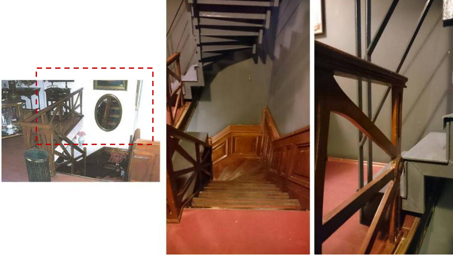
Şekil 5.50 : Çelik merdiven eki, restorasyon öncesi ve sonrası durum. (Geçmiş Fotoğraf: Url-5.7- Güncel Fotoğraflar: Kişisel arşiv).
