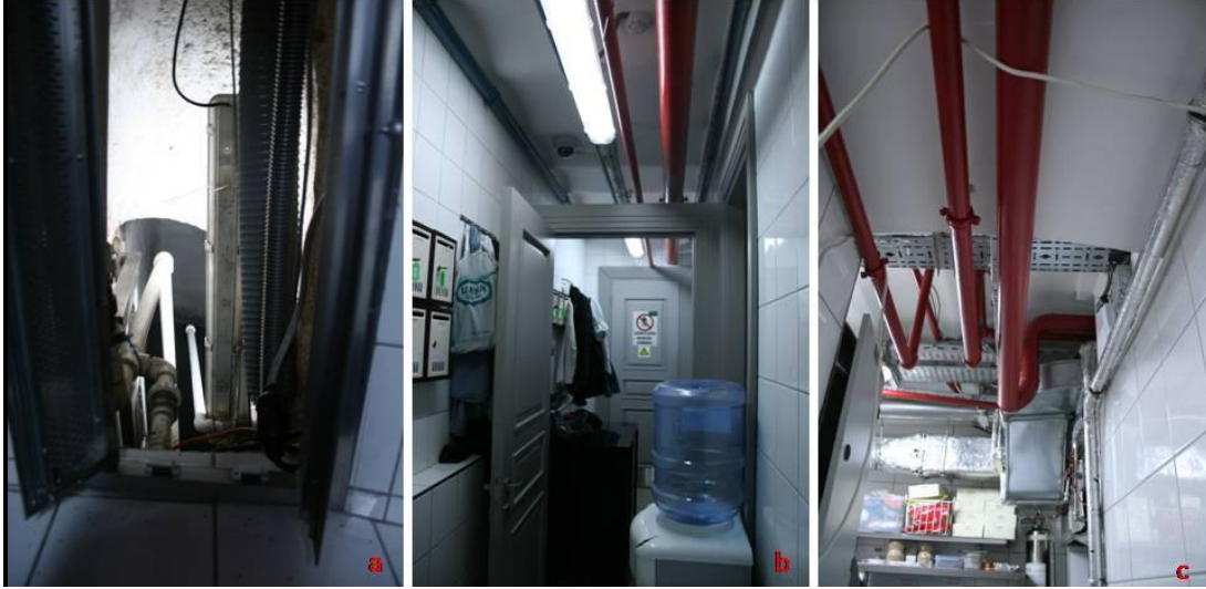
Şekil 5.46 : a-Su deposu olarak kullanılan sarniç, b-c depo olarak kullanılan bodrum kattan görünüm (Kişisel arşiv).
