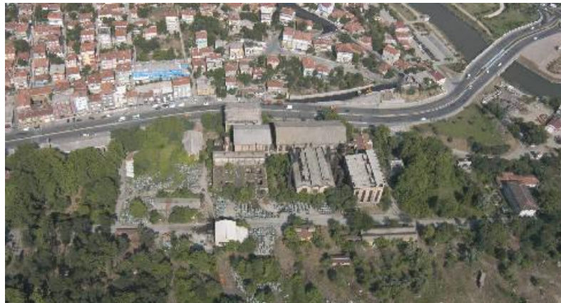
Şekil 2.6 : Silahtaraga Elektrik Santrali, Santral İstanbul Projesi. (Url-2.3)
