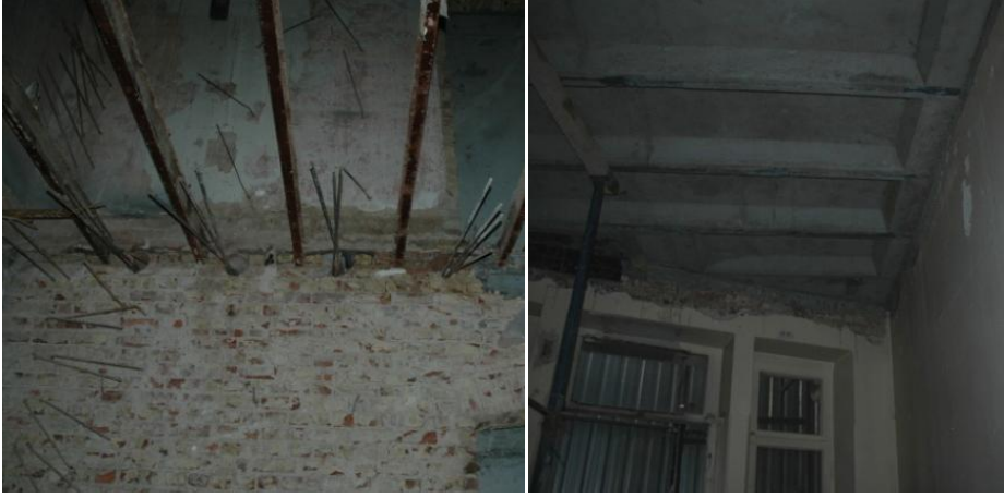
Şekil 5.6 : Yenilenen kat döşemeleri, restorasyon öncesi ve sonrası (Y.M.A arşivi).
