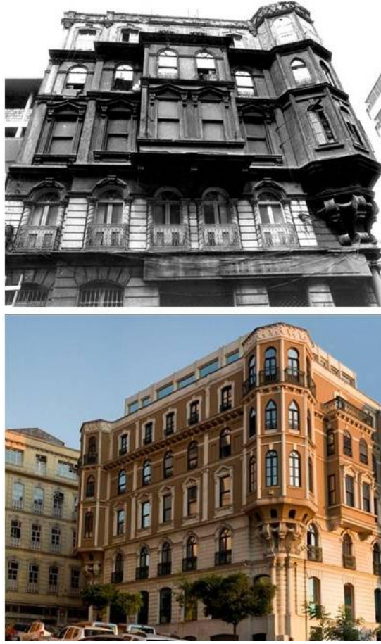
Şekil 5.15 : Restorasyon öncesi ve sonrası yapıdan görünüm (Url-5.1).
