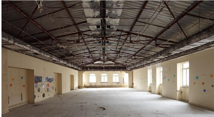
Şekil 5.34 : 1950'lerde eklenen kat. Restorasyon öncesi (Fotoğraf: C.Emden).
