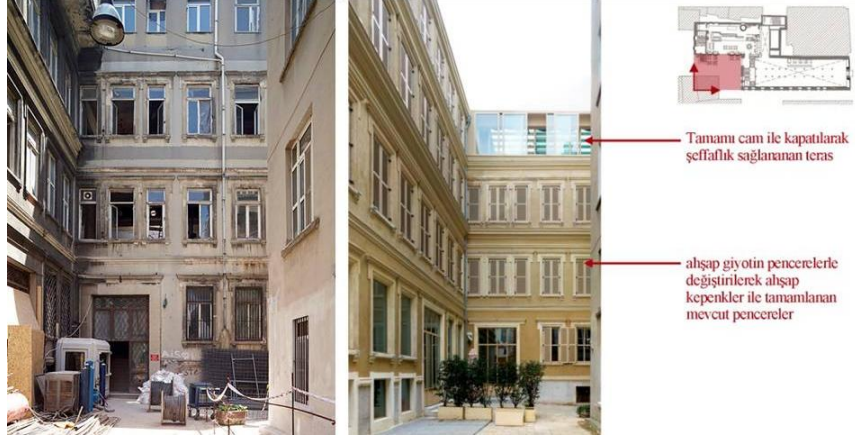
Şekil 5.25 : Yapının batı cephesi ve değişiklikler (Fotoğraf:C.Emden, plan HT ve Mimarlar).
