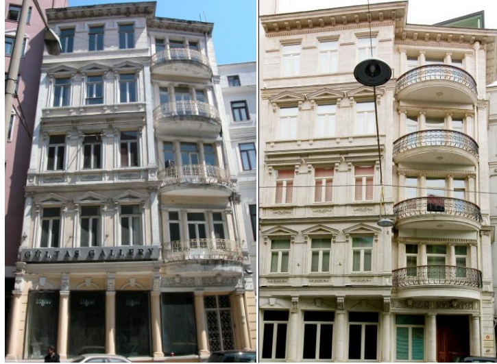
Şekil 5.4 : Bina Cephesi Restorasyon öncesi ve sonrası (Y.M.A).
