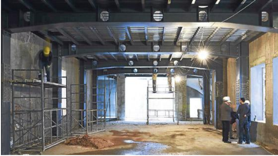
Şekil 5.36 : Döşemeleri taşıması için oluşturulan enine çelik çerçeve sistemi (Fotoğraf:C.Emden).
