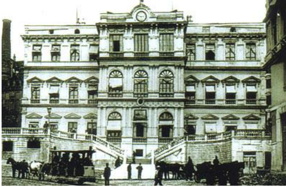
Şekil 3.7 : Altıncı Daire-i Belediye Binası (Tarih Vakfı, 2008).
