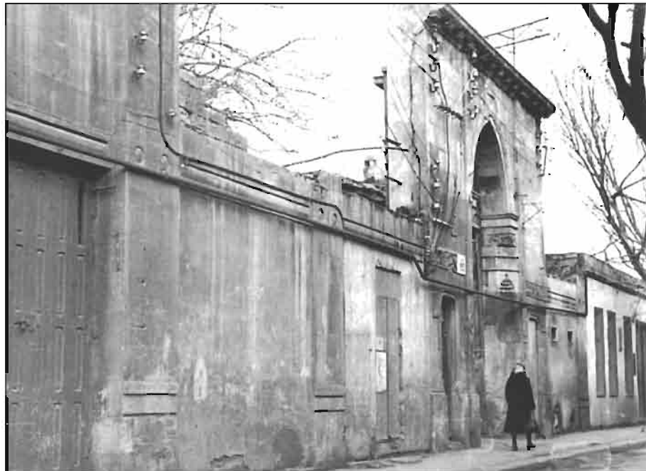
Suraxanskaya küçəsi, 155. Məscid binasının hasarının ümumi görünüşü. 1883-cü il.
