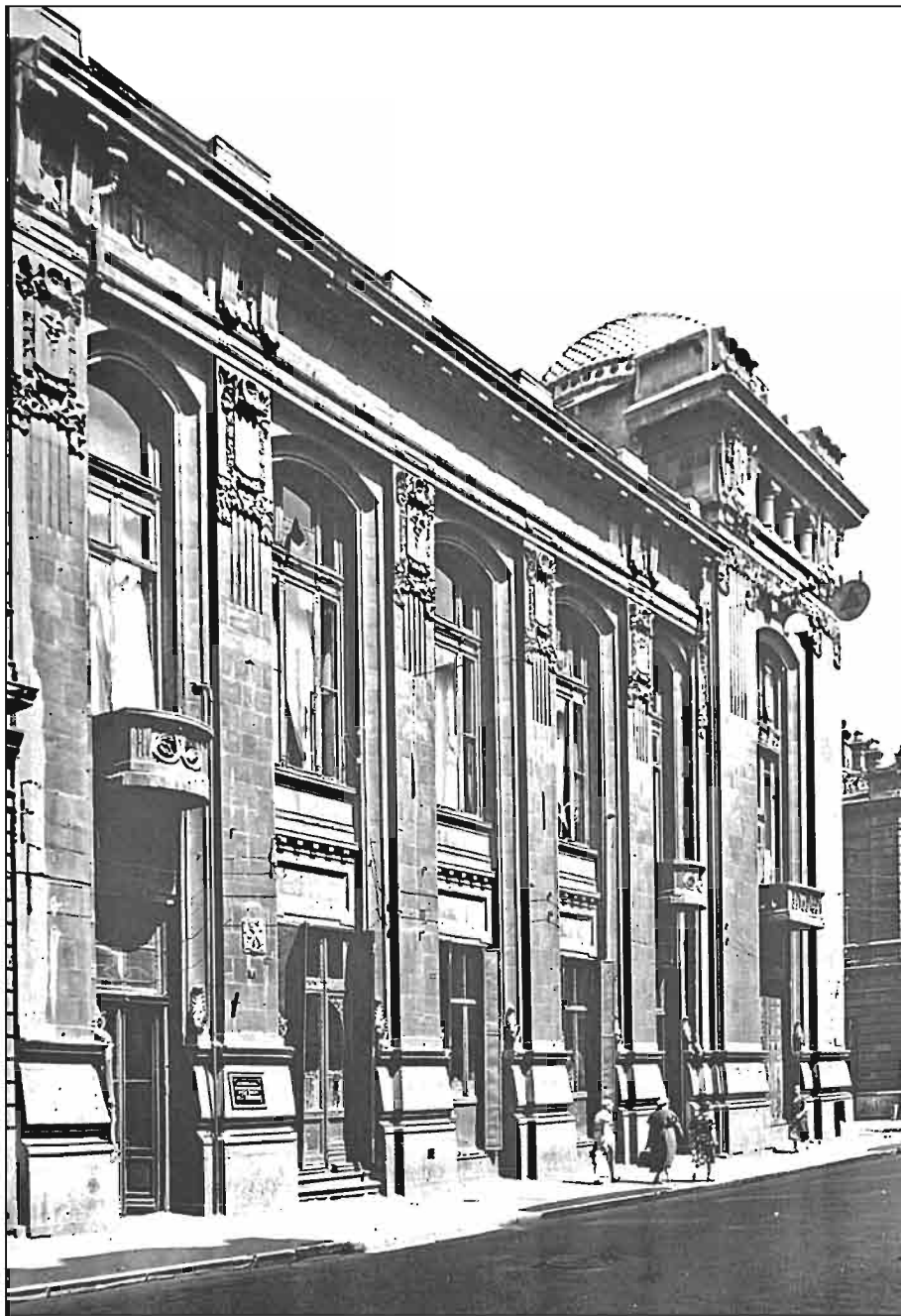
Qorçakovskaya küçəsi 3. "Şimal bank" binasının cənub fasadı.
