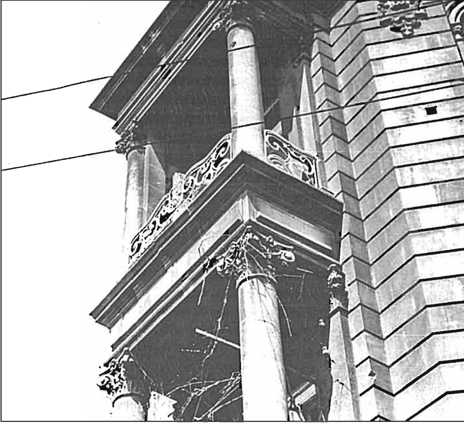
Qoqol küçəsi, 28. Teymur bəy Aşurbəyovun yaşayış evinin fasadının fraqmenti.
