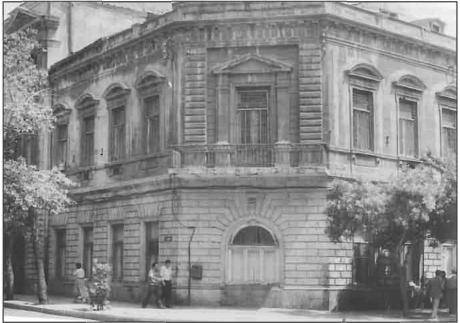
Krasnovodskaya küçəsi., 12. Ağa Musa Nağıyevın qış İctimai məclisinin binasının ümumi görünüşü. Mülki mühəndis A.S. Kandinov. 1890-cı illər.
