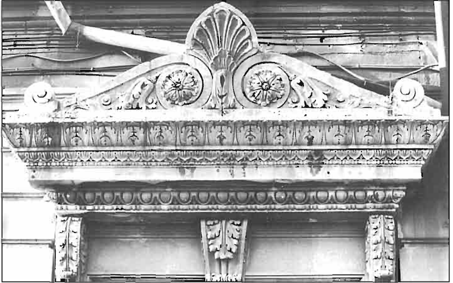
Dəniz kənarı küç., 65. N. Əmiraslanovun yaşayış evi fasadının detali.
