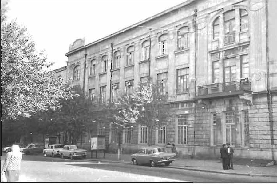
Suraxanskaya küçəsi, 216. Məktəb binasının şimal fasadının ümumi görünüşü. 1912-ci il.
