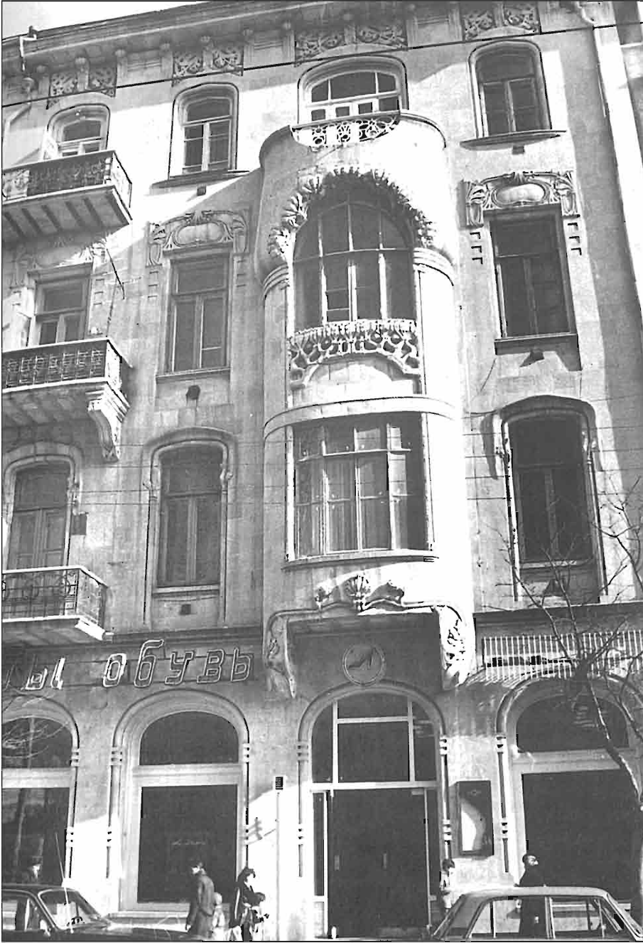
Telefonnaya küçəsi, 4. Ağa Musa Nağriyev yaşayış evinin şimal fasadının ümumi görünüşü.
