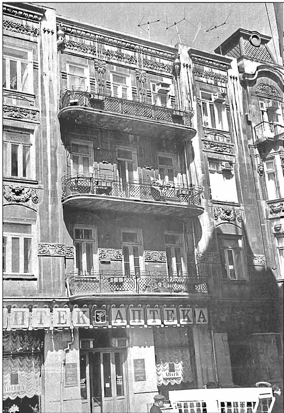
Qorçakovskaya küçəsi 16-18. 18 saylı yaşayış evinin qərb fasadının ümumi görünüşü.
