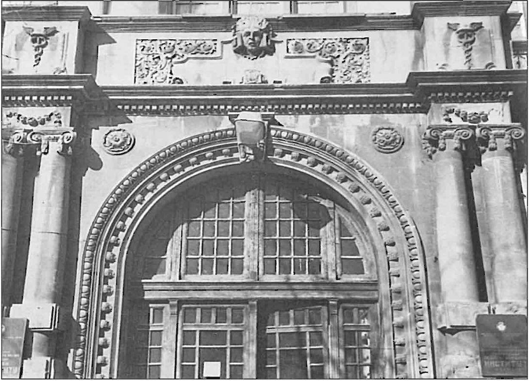
Merkuryevski küç. 39. Kommersiya peşə məktəbi binası. Giriş portalı.
