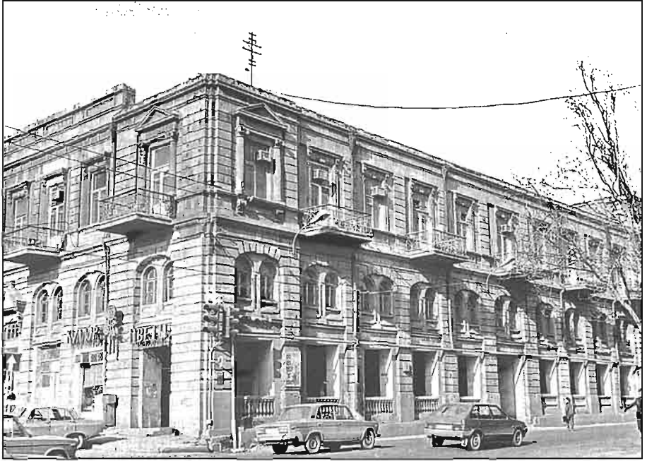
Bazarnaya küç., 9. "İslamiya" karvan saray binasının şərq fasadı. Mülki mühəndislər N.P. Tverdoxlebov, A.S. Kandinov. 1884-1885-ci illər.
