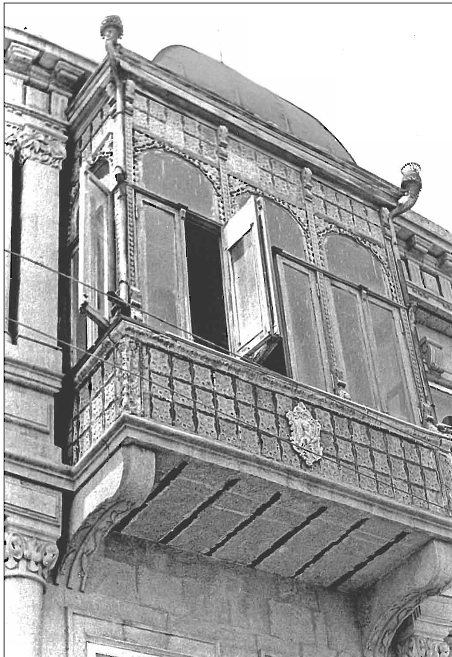
Yuxarı Təzə-pir küç., 121. Hacıyevlərlə məxsus yaşayış evinin şərq fasadının fraqmenti. Eynən-şüştəbənd.
