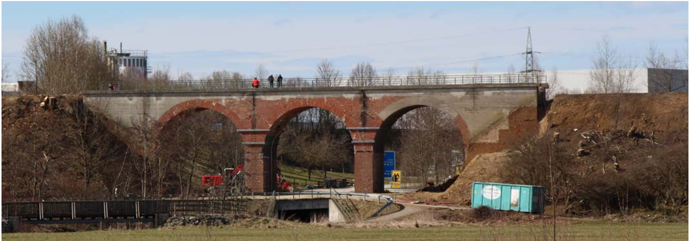
Ansicht des zu erneuernden Eisenbahnviadukts in Stetten kurz vor seinem Abriss.
