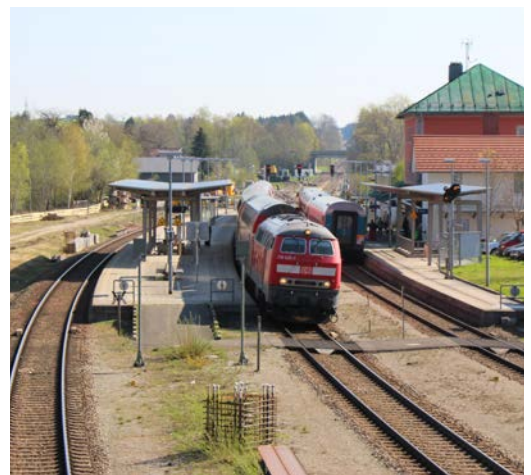
Die Bahnsteige in Hergatz werden durch Nachrüstung von Aufzügen vollkommen barrierefrei gestaltet.
