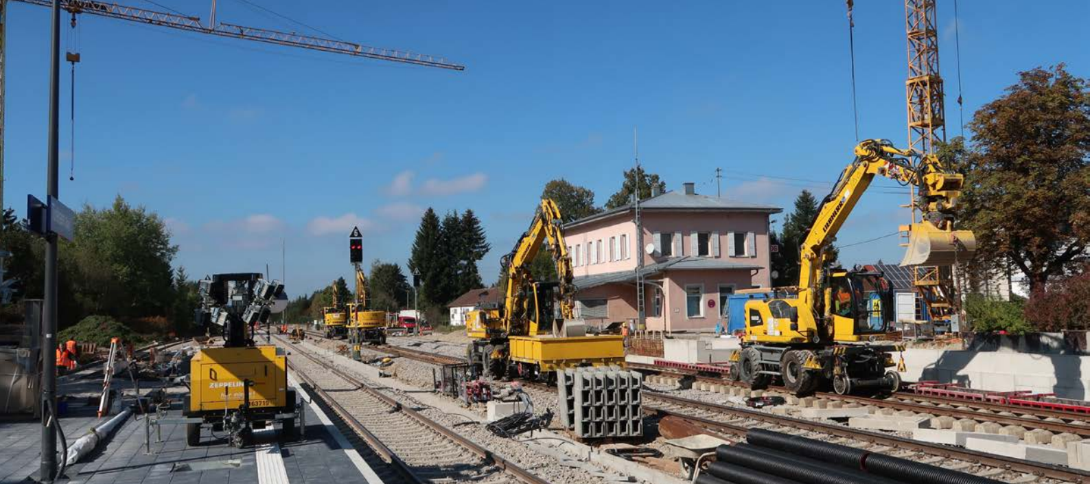
Der Bahnhof Türkheim (Bay) wurde 2018 umfassend umgebaut und modernisiert.
