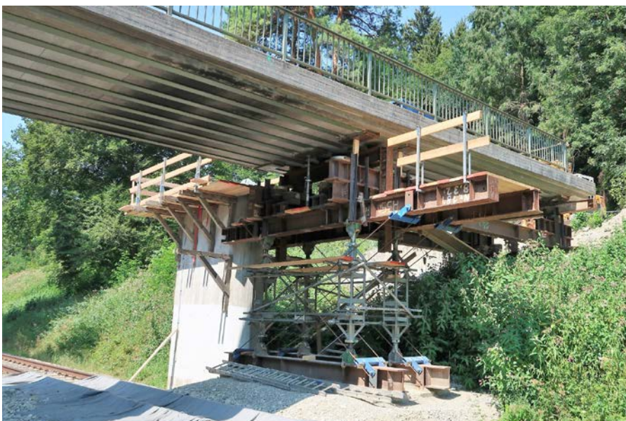
Anhebung der Straßenbrücke in Gernstall um 0,85 Meter. Hierzu wurde der Überbau für den Erhöhung der Widerlager seitlich verschoben und gelagert.
