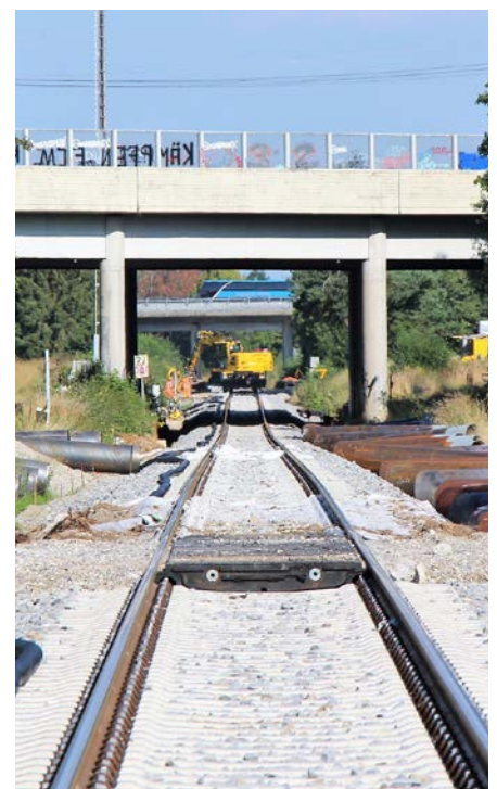
Zwischen Memmingen und Buxheim wurde die Gleistrasse unter der Autobahnbrücke abgesenkt.
