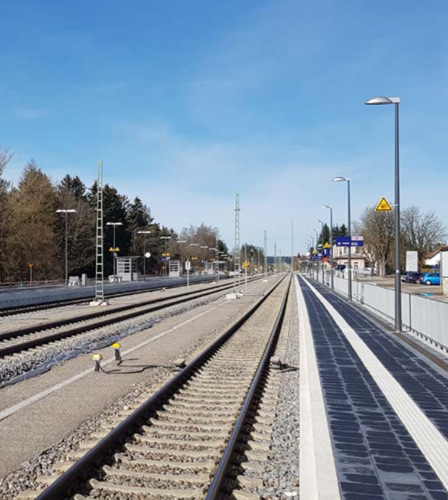
Die Bahnsteige in Türkheim (Bay) sind nun barrierefrei erreichbar.
