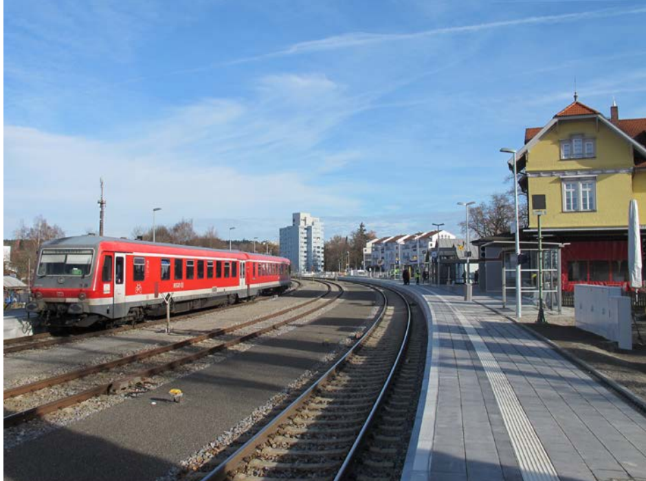
Der Bahnhof Leutkirch ist seit November 2017 barrierefrei ausgebaut, Aufzüge und Bahnsteighöhe erlauben den stufenlosen Zustieg in die Züge.
