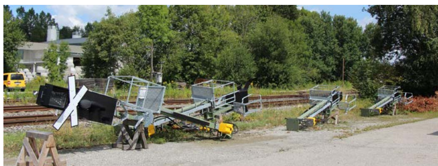
Neue Signale für das elektronische Stellwerk in Kißlegg kurz vor der Montage.
