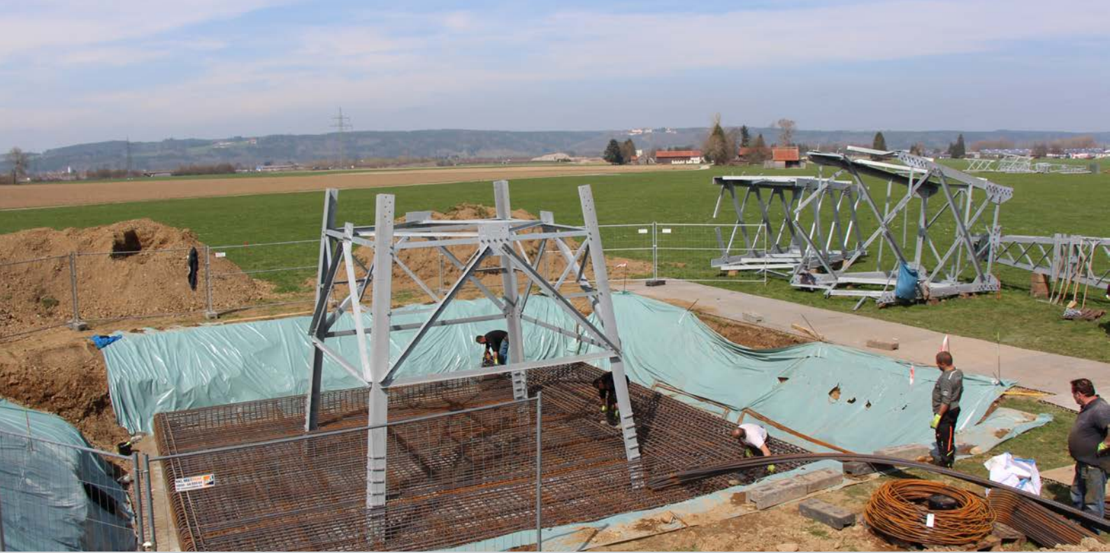
Die Arbeiten am Umrichterwerk Leutkirch und dessen Anbindung an die bestehende Überlandleitung werden auch in diesem Jahr mit großem Einsatz fortgesetzt.
