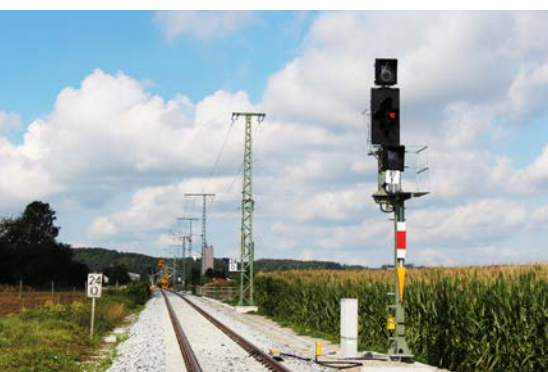
Die Strecke wird elektrifiziert und mit neuester Technik ausgestattet.
