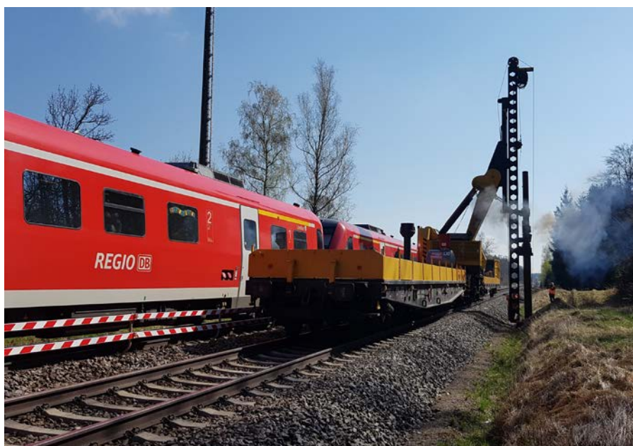
Die Gründung der Oberleitungsmaste erfolgt unter Einsatz von Spezialrammgeräten. Die Arbeiten werden umweltschonend vom Gleisbereich aus durchgeführt.
