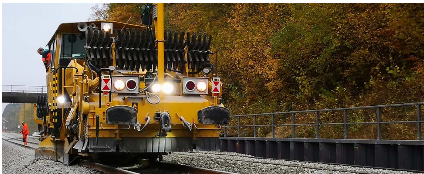
Oberbauarbeiten zur Gleisabsenkung im Bereich Eresinger Straße zwischen Geltendorf und Kaufering
