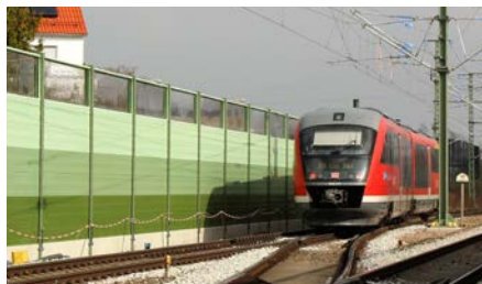
Schallschutzwände (hier in Memmingen) bieten effektiven Schutz bei geringem Flächenverbrauch
