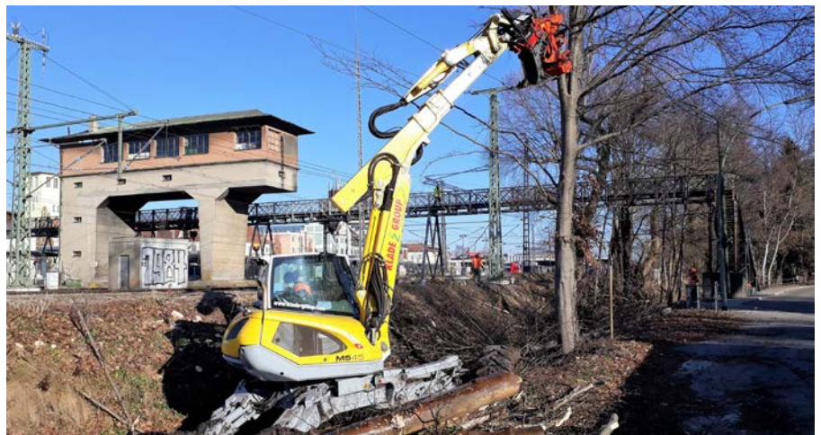
Überall entlang der Strecke finden Vegetationsarbeiten statt, um Raum für die Oberleitung zu schaffen.
