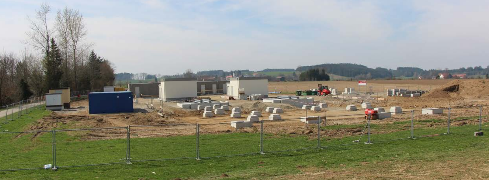
Auf halber Strecke: Das im Bau befindliche dezentrale Umrichterwerk Leutkirch.
