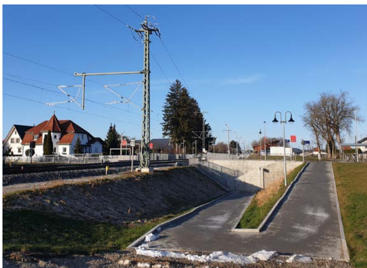
Die beiden neuen Bahnsteige in Stetten (Schwab) sind mittlerweile barrierefrei über Rampen erreichbar.
