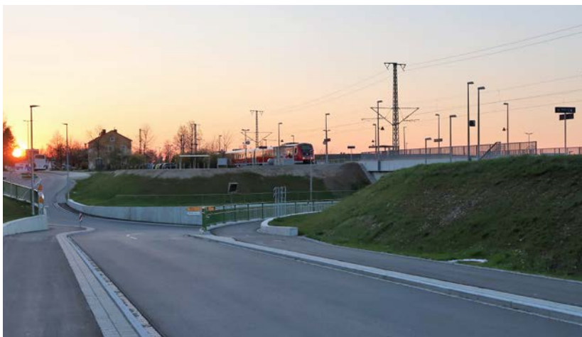
Die neue Straßenunterführung und Bahnsteige im Bahnhof Sontheim (Schwab) ergänzen sich und erlauben einen sicheren und komfortablen Zugang zu den Zügen.
