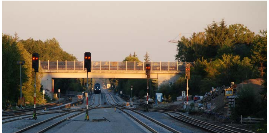
Die Gleise und Weichen im Westteil des Bahnhofs Kaufering wurden abgesenkt, um die notwendige lichte Höhe für den Einbau der Fahrleitungsstruktur zu erhalten.
