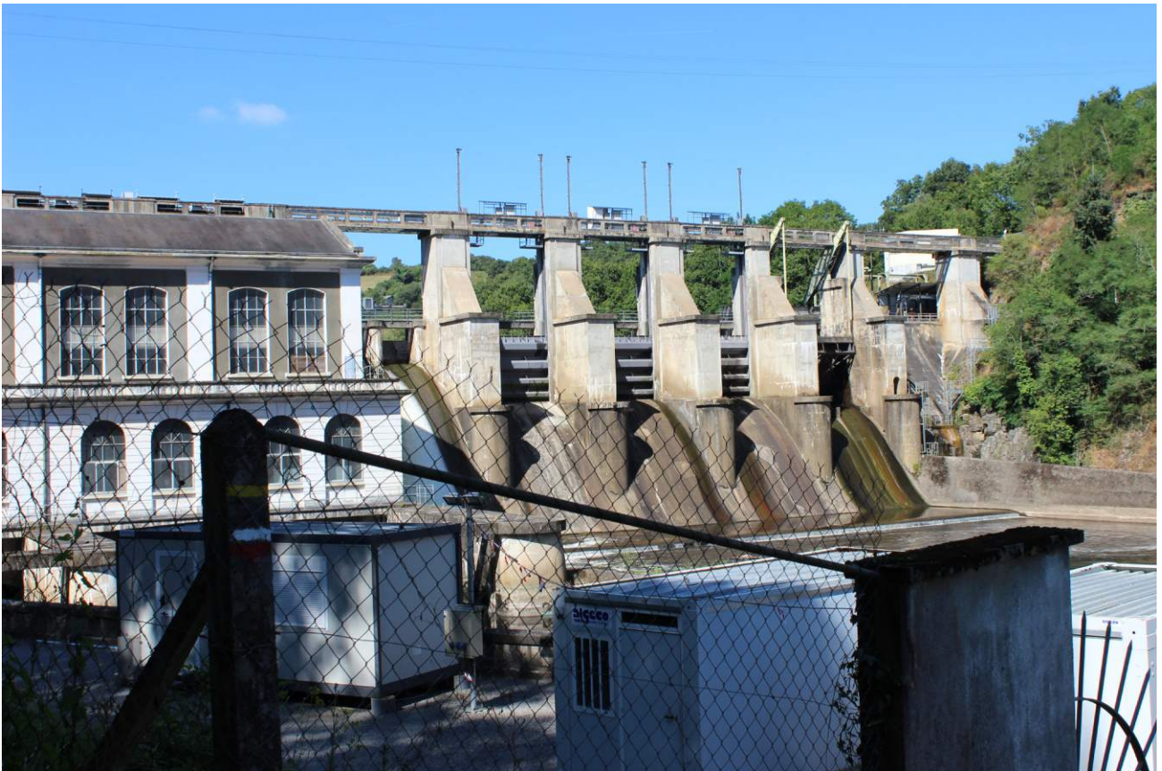
barrage de la roche aux Moines
