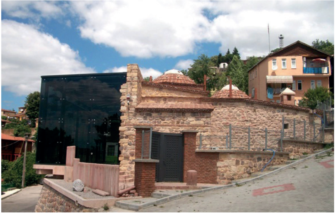
Resim IV: İzmit Süleyman Paşa Hamamı'nın Restorasyon Sonrası Görünümü 3
