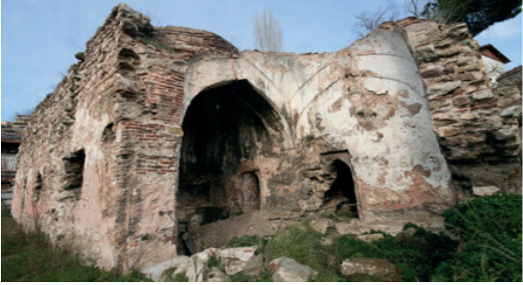
Resim III: İzmit Süleyman Paşa Hamamı'nın Restorasyon Öncesi Görünümü 2
