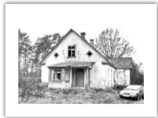
Artura Stradiņa ģimenes mājas Kalnāres 2002. gada 2. novembrī. (Foto: J. Lācis)
