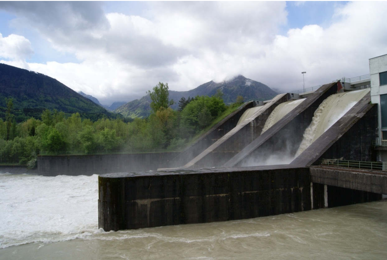
Abb. 172: Verbund Kraftwerk Feistritz im Rosental; Hochwasserentlastung in Betrieb
