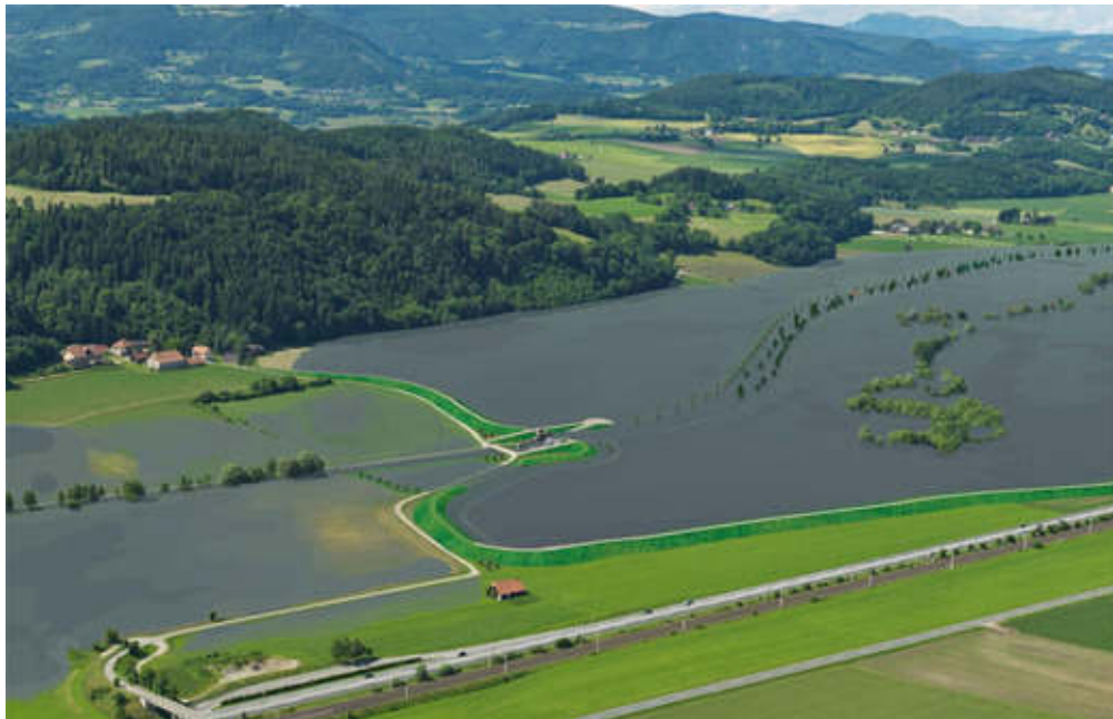
Abb. 171: Hochwasserrückhaltebecken Zollfeld (simulierte Hochwassersituation). Nur eine begrenzte Wassermenge fließt unmittelbar durch das Entlastungsbauwerk flussab. Ein großer Teil der Hochwasserwelle wird im Becken retendiert und kommt später zum Abfluss.
