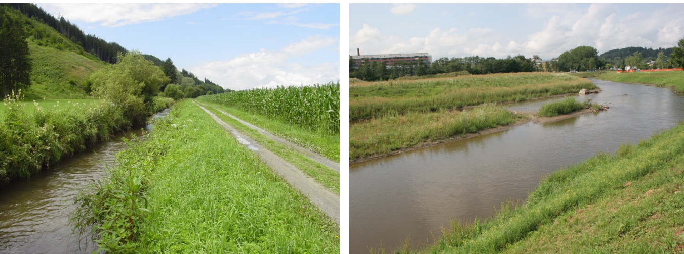
Abb. 55: Links: Die Glan bei Seidlhof; Rechts: Die Glan nach der baulichen Umleitung beim LKH Klagenfurt (Fotos: KERSCHBAUMER)
