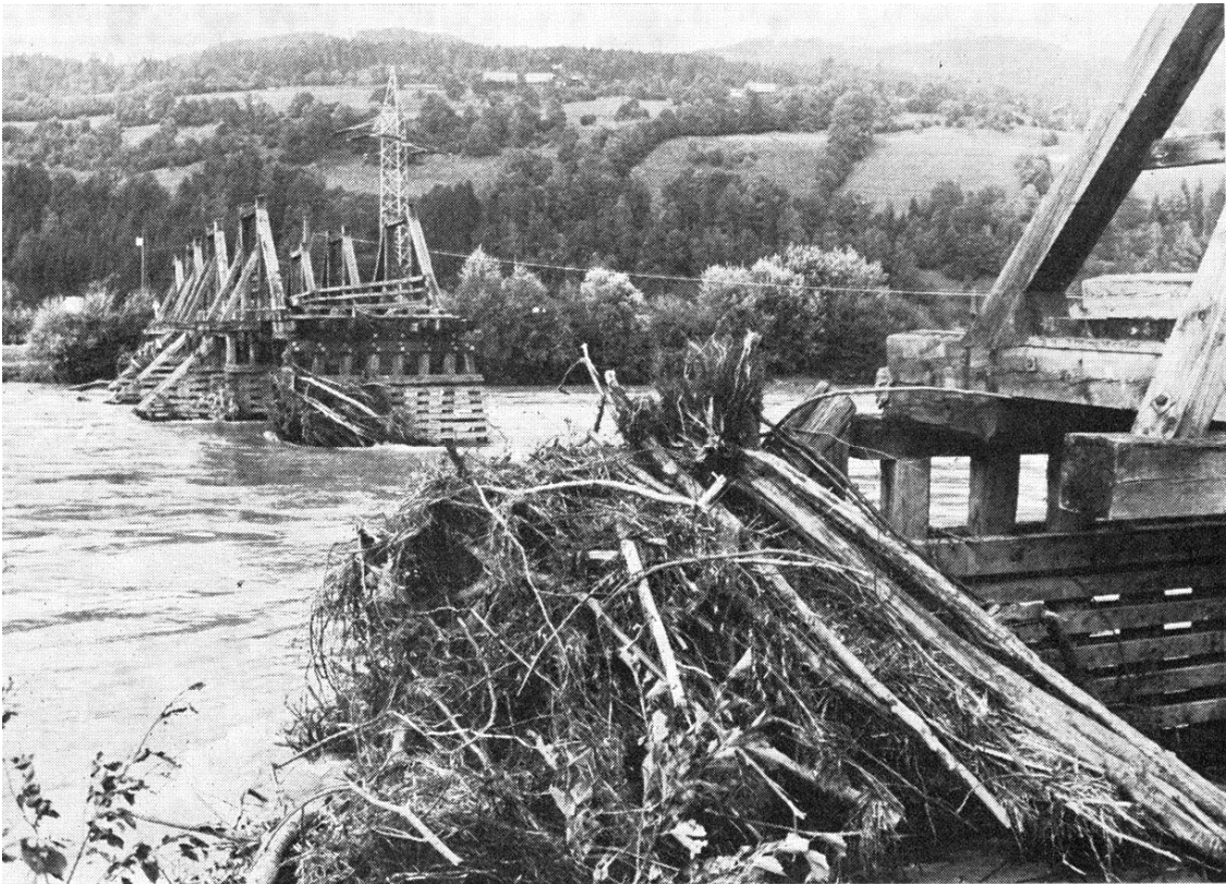
Abb. 122: Foto: zerstörte Brücke Pattendorf (Paternion) 1965
