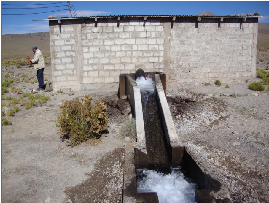
Figura No. 2-28 Fotografía del Pozo PA-6
