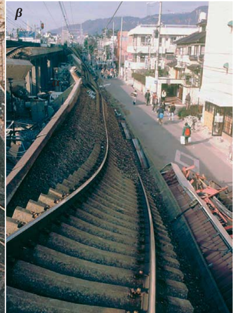
Εικ. 2.18α,β. Hanshin - Kobe Ιαπωνία, σεισμός 1995. Το σιδηρο- δρομικό δίκτυο έπαθε σοβαρές ζημιές και έμεινε εκτός λειτουργίας για έξι μήνες περίπου.
