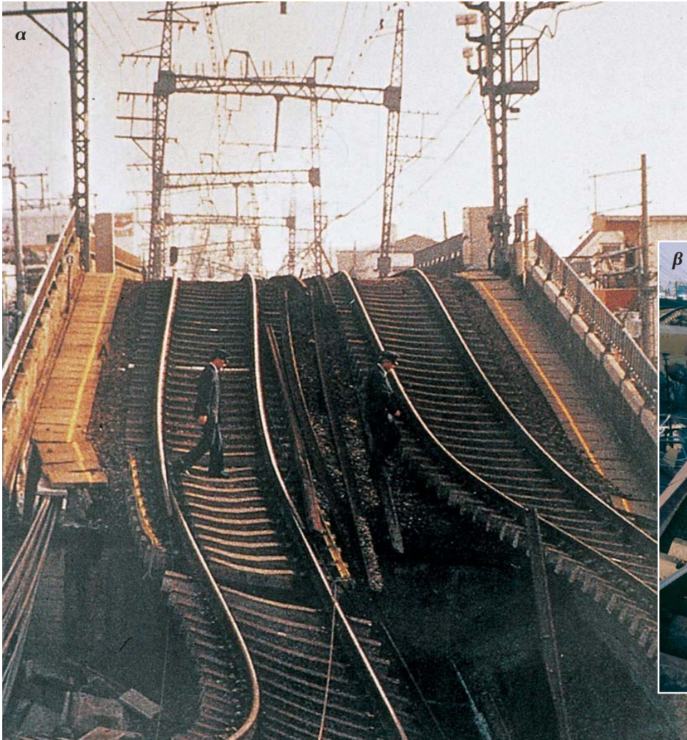
Εικ. 2.18α,β. Hanshin - Kobe Ιαπωνία, σεισμός 1995. Το σιδηρο- δρομικό δίκτυο έπαθε σοβαρές ζημιές και έμεινε εκτός λειτουργίας για έξι μήνες περίπου.
