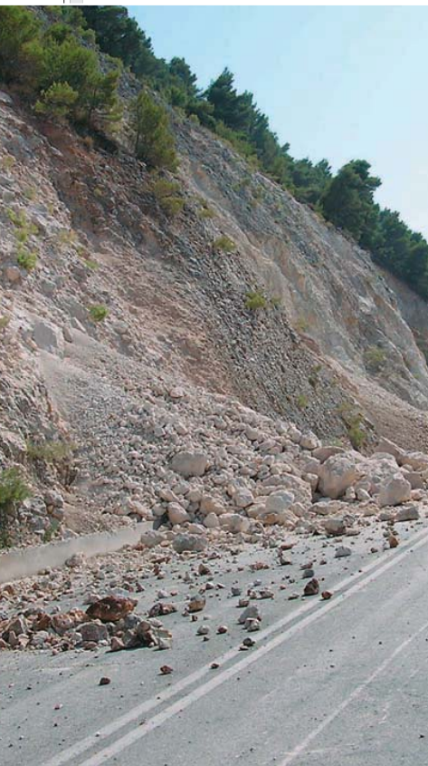
Εικ. 1.22. (αριστερά) Λευκάδα, σεισμός 2003 ( M=6,4 ). Πτώσεις βράχων στο δυτικό οδικό άξονα του νησιού. Αναγκαστική διακοπή κυκλοφορίας.
