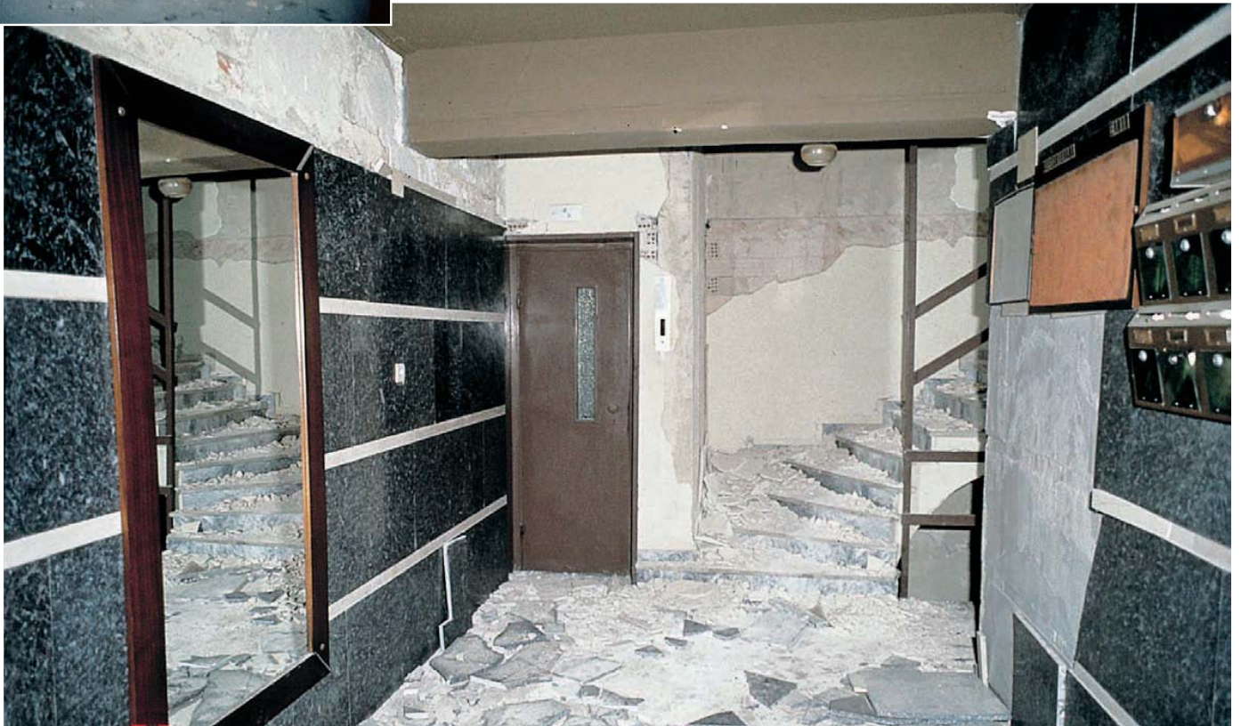
Εικ. 3.17. (κάτω) Καλαμάτα, σεισμός 1986. Οι ένοικοι δε χρησιμοποίησαν τον ανελκυστήρα για την έξοδό τους από την πολυκατοικία μετά το τέλος της σεισμικής δόνησης. Ο κίνδυνος όμως παραμόνευε και στις σκάλες, από τους πεσμένους σοβάδες, τα σπασμένα τζάμια και μάρμαρα.
