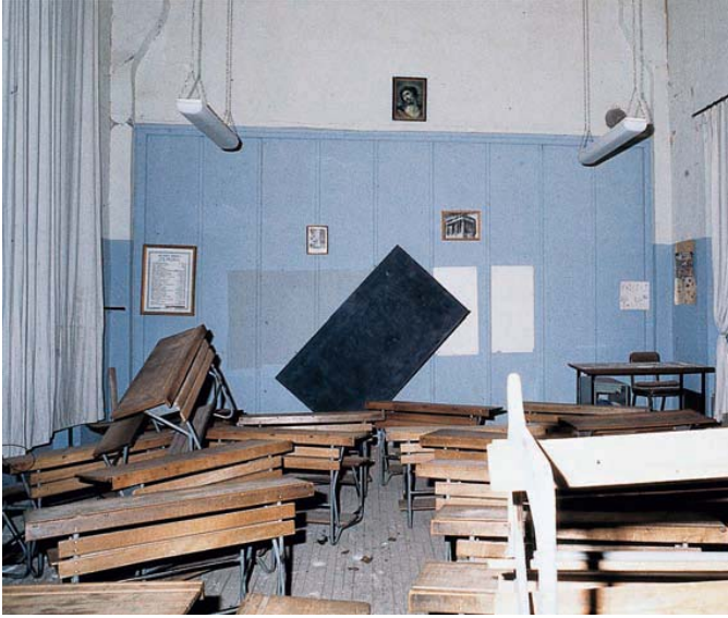
Εικ. 4.11. (πάνω) Ο πίνακας δεν ήταν καλά στερεωμένος με κλειστά άγκιστρα. Επικινδυνότητα για μαθητές και εκπαιδευτικούς.
