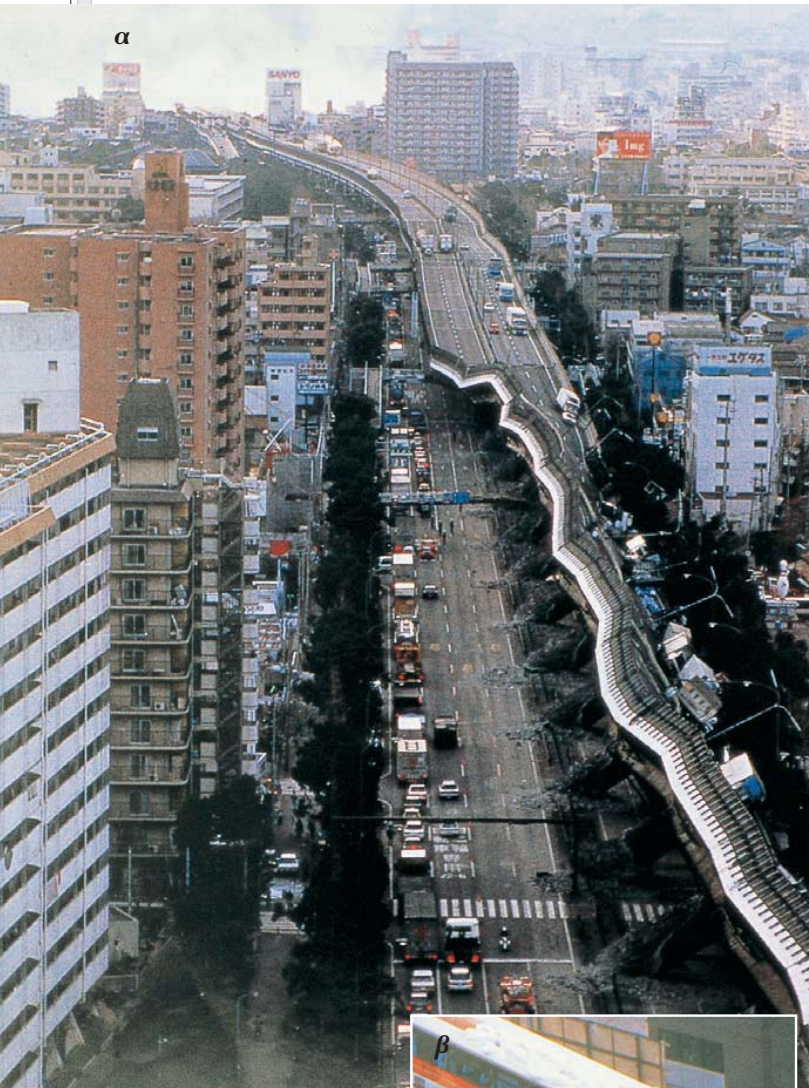
Εικ. 2.17α,β. Hanshin - Ιαπωνία, σεισμός 1995 (M=6,9). Ο αυτοκινητόδρομος ταχείας κυκλοφορίας στο Hanshin κατέρρευσε σε μήκος περίπου 550 μέτρων κατά τη διάρκεια του σεισμού συμπαρασύροντας 12 οδηγούς που ήταν στα οχήματά τους. Στις 5:46 το πρωί (τοπική ώρα) ο δρόμος ήταν σχεδόν άδειος. Αν ο σεισμός είχε γίνει λίγο αργότερα τα θύματα θα ήταν πάρα πολλά.
