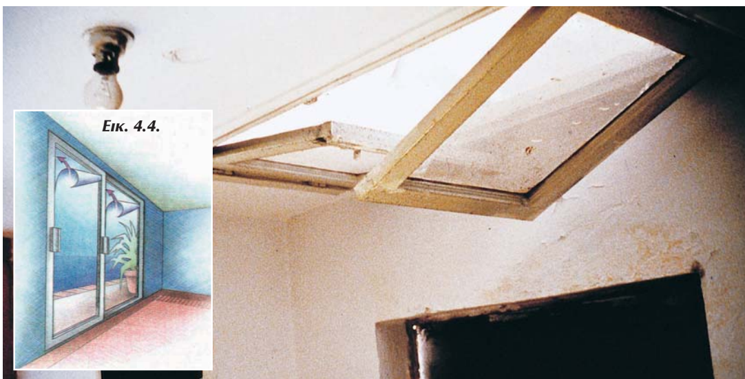
Εικ. 4.5. Μισάνοιχτο παράθυρο στην οροφή ενός διαδρόμου σχολείου. Τα θραύσματα κατά τη διάρκεια ενός σεισμού θα τραυματίσουν τους μαθητές και θα παρεμποδίσουν την ασφαλή έξοδό τους από το κτίριο.
