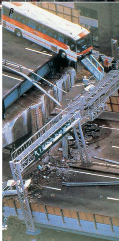
Εικ. 2.17α,β. Hanshin - Ιαπωνία, σεισμός 1995 (M=6,9). Ο αυτοκινητόδρομος ταχείας κυκλοφορίας στο Hanshin κατέρρευσε σε μήκος περίπου 550 μέτρων κατά τη διάρκεια του σεισμού συμπαρασύροντας 12 οδηγούς που ήταν στα οχήματά τους. Στις 5:46 το πρωί (τοπική ώρα) ο δρόμος ήταν σχεδόν άδειος. Αν ο σεισμός είχε γίνει λίγο αργότερα τα θύματα θα ήταν πάρα πολλά.
