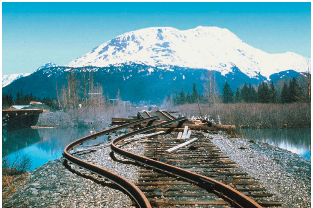
Εικ. 2.19. Αλάσκα, σεισμός 27-3-1964. Κατά τη διάρ- κεια του σεισμού ( M=9,2 ) οι γραμμές του τραίνου λύγισαν και καταστράφη- καν κάποιες γέφυρες του σιδηροδρομικού δικτύου.
