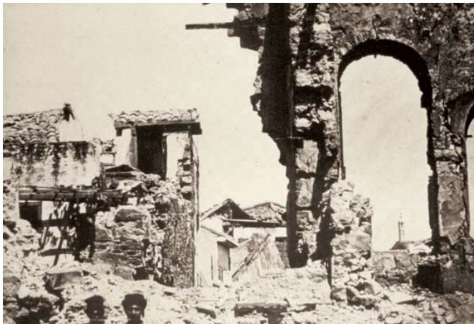
Εικ. 2.1. Χίος, σεισμός 1881 ( M=6,5 ). Εκτεταμένες καταστροφές κυρίως στο νοτιοανατολικό τμήμα του νησιού. Τα Νένιτα, το Βουνό, η Φλάτσια, η Καλαμωτή, η Κοινή, η Καλλιμασιά και τα Διδυμα, επλήγησαν κυρίως από το σεισμό. Μεγαλύτερο το πρόβλημα (θάνατοι και υλικές ζημιές) ήταν στις συνοικίες των Ελλήνων, των Τούρκων και των Εβραίων. Οι Φράγκοι ζούσαν σε καλύτερα κατασκευασμένα σπίτια, με μεγάλους κήπους, και έτσι είχαν λιγότερες απώλειες.
