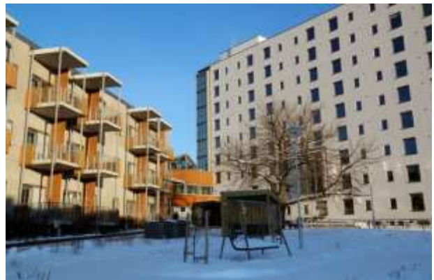
Martin Skatvedts vei - Omsorg+ Boliger Ferdigstilt desember 2018
