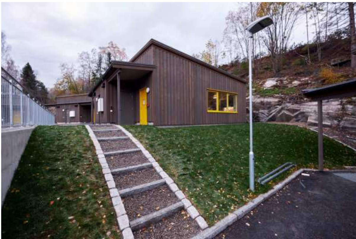
Boliger til vanskeligstilte – Ferdigstilt høsten 2018
