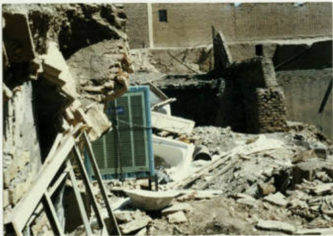
۷- قسمت دیگری از پشت بام حمام - دید از جنوب (در حال تخریب)
