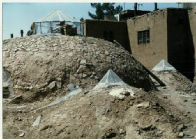
۱۲- نمای جنوبی و گنبد صحن اصلی حمام
