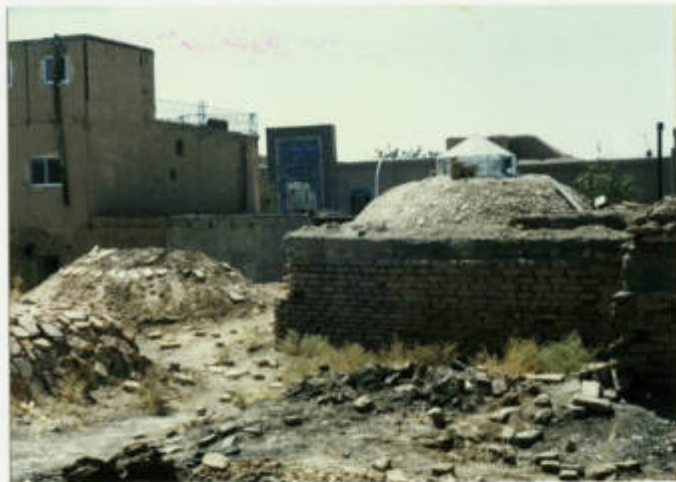
۶- قسمتهای جنوبی - بام ، مشرف به مدرسه فخریه (در حال تخریب)
