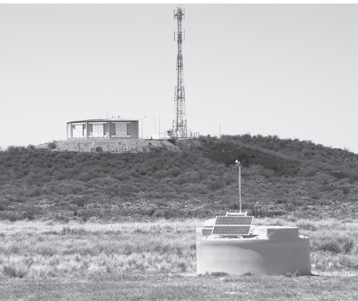
Tanque de água e edifício de um dos telescópios do Laboratório Pierre Auger, na Argentina, para o estudo da radiação cósmica
