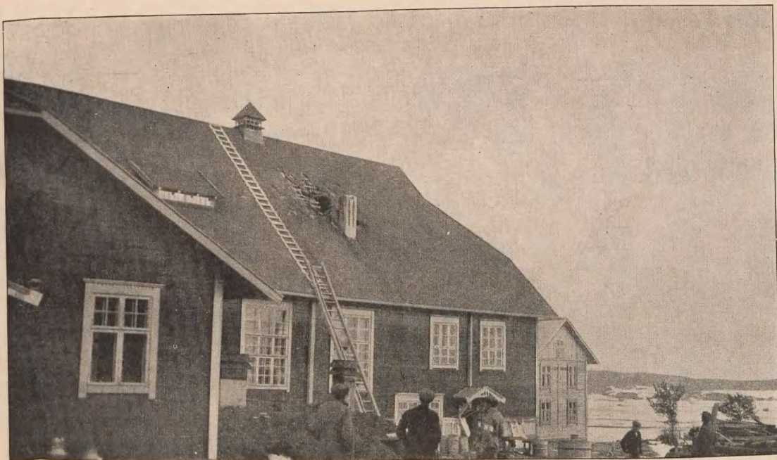
Skolehuset Orivesi. Granatgjennemslag i taget.
