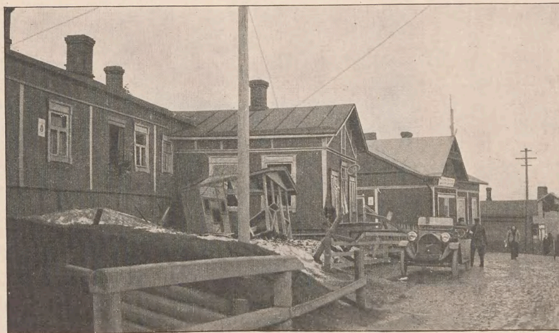
Løbegravens fortsættelse (tilvenstre) ovenfor landsveien. Granatindslag i husene.
