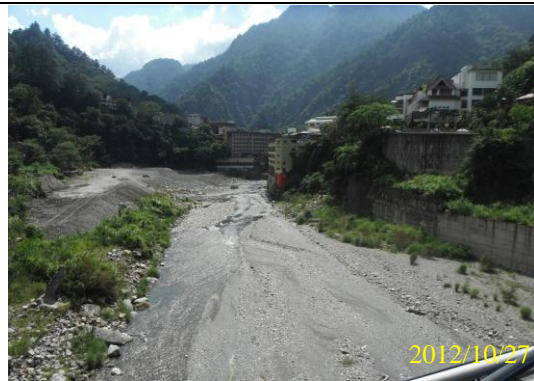
照片 6-15 天輪壩下游-谷關橋(豐水期)
