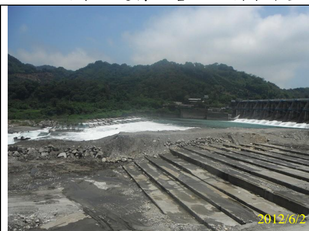
照片 4-9 石岡壩現況
