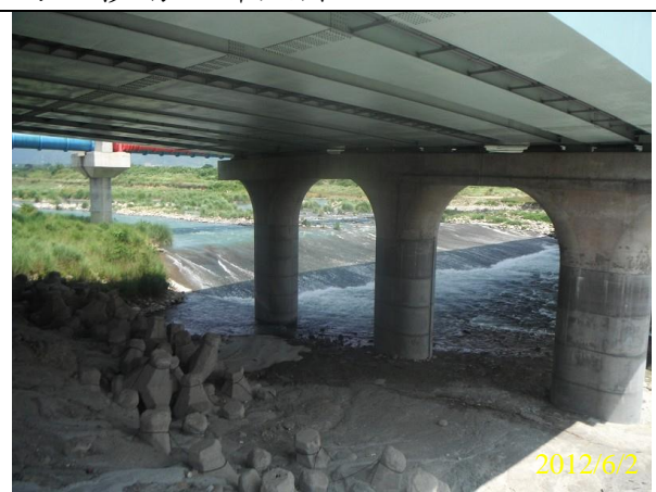
照片 4-10 后豐大橋下方固床工現況
