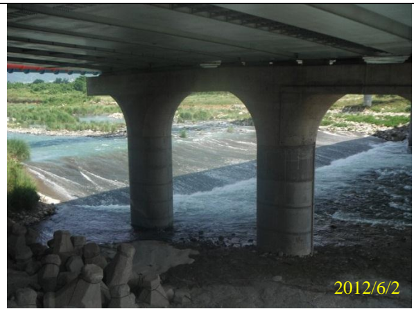
照片 6-35 后豐大橋固床工
