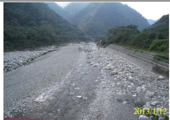
照片 6-14 裡冷橋(枯水期)
