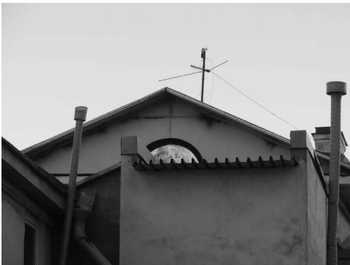
10. Здание по адресу: Петроградская наб., 24, Пинский пер., 2. Корпус по Петроградской наб. Фрагмент западного фасада, зашитое окно фронтона. На первом плане - двухэтажная пристройка 2000-х годов, искажающая исторический облик здания. Фото: Шипилова Г.А.
