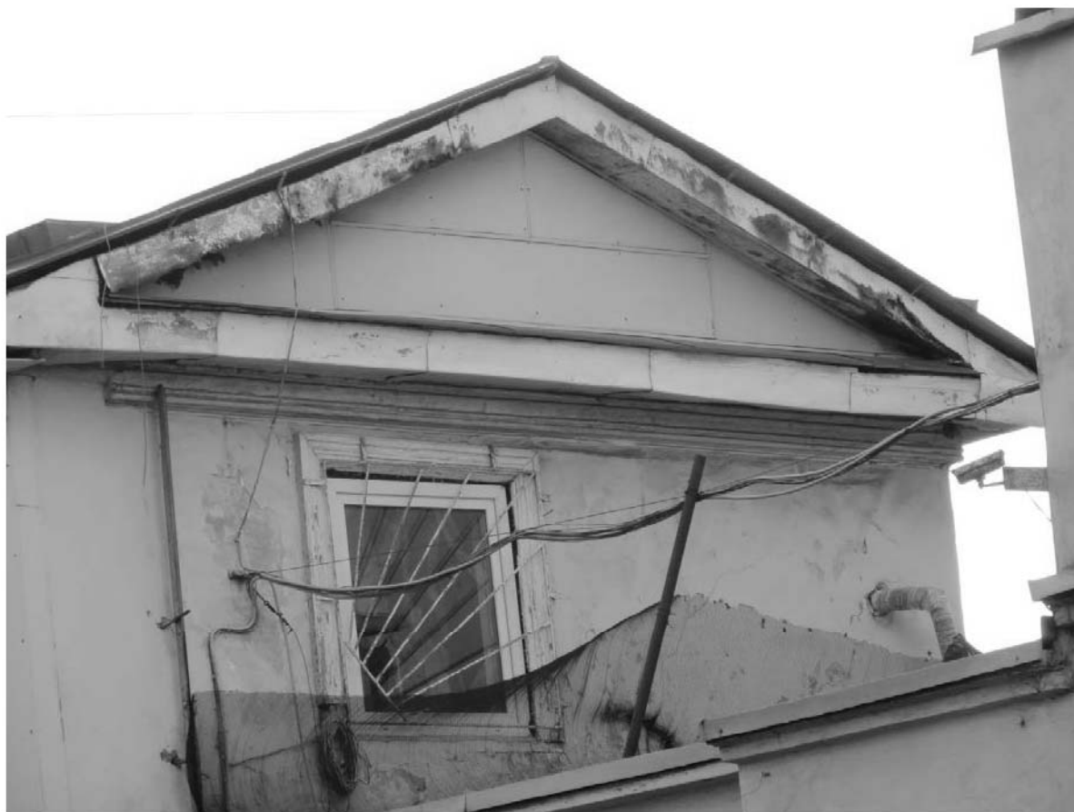
6. Здание по адресу: Петроградская наб., 24, Пинский пер., 2. Корпус по Пинскому переулку. Фронтон, профилированный штукатурный фриз, оформление оконного проёма. Фото: Шипилова Г.А.
