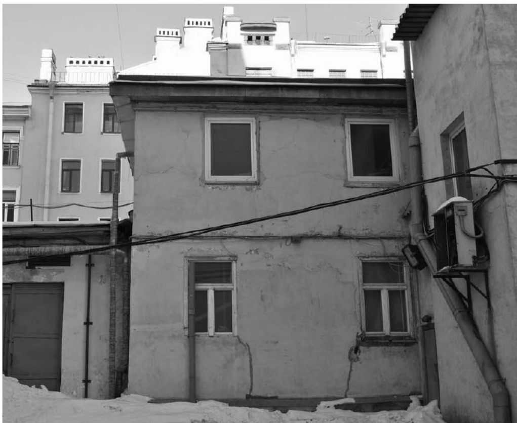
9. Здание по адресу: Петроградская наб., 24, Пинский пер., 2. Дворовые фасады. Фрагмент южного фасада корпуса по Пинскому переулку. Фото: Шипилова Г.А.
