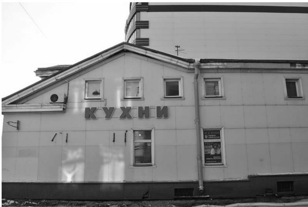
5. Здание по адресу: Петроградская наб., 24, Пинский пер., 2. Фрагмент северного фасада. Фото: Шипилова Г.А.
