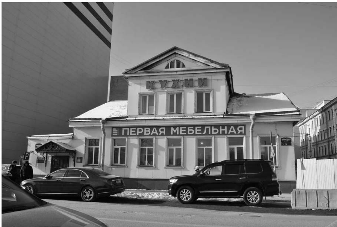
2. Здание по адресу: Петроградская наб., 24, Пинский пер., 2. Корпус по Петроградской набережной. Лицевой восточный фасад. Фото: Шипилова Г.А.
