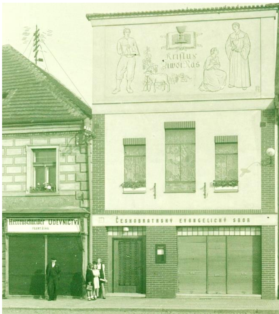
Nově opravená budova
