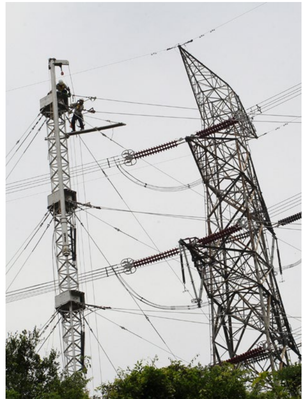
架空電纜技術人員正在約 70 呎高的臨時電塔上接駁導線。建造一個臨時電塔需時十多天，較重建傳統輸電塔快十多倍。
