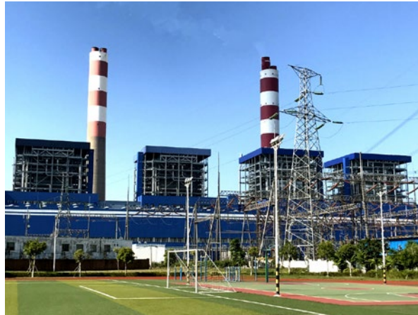
廣西防城港一期及二期燃煤發電廠
