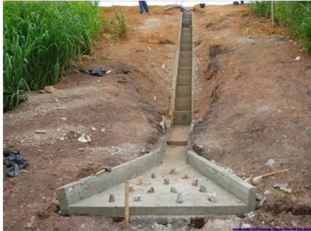
**Figura 2.3.2.7.2-6: Estruturas de Dissipação de Energia**
