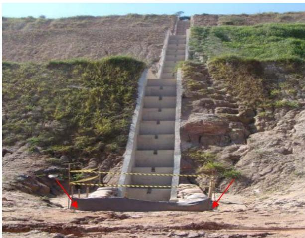
**Figura 2.3.2.7.2-5: Descida d'água**
