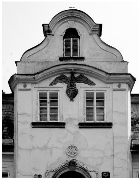
Průčelí domu U Pelikána
