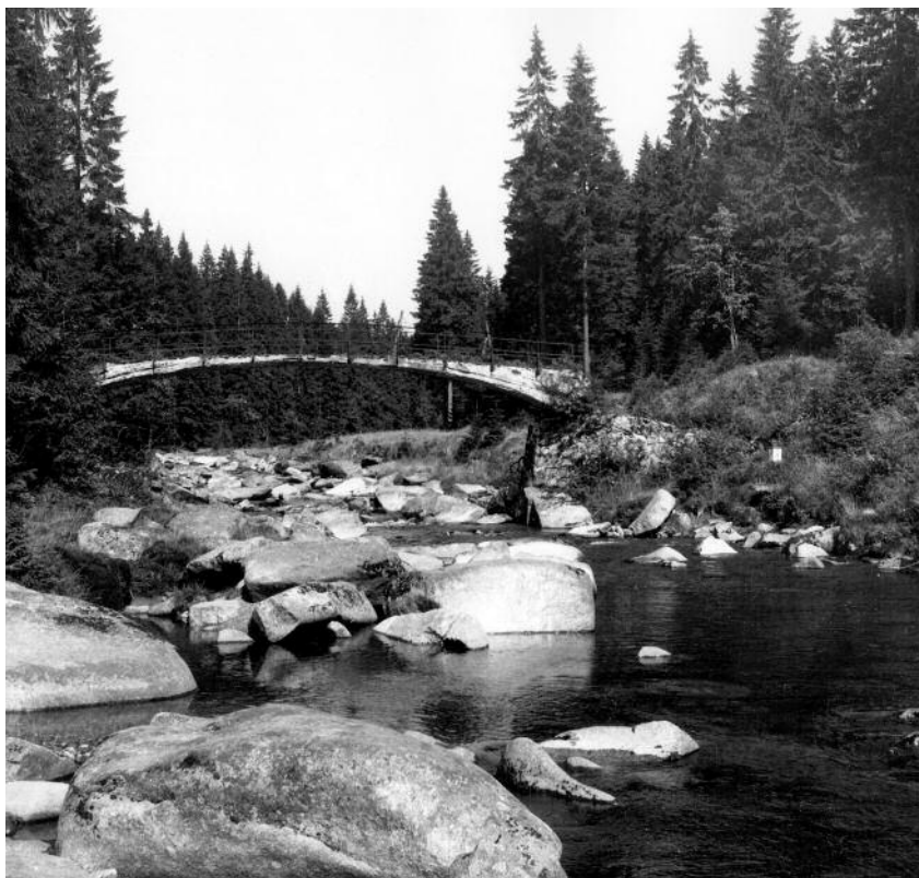
Starý železobetonový most přes Jizeru nad soutokem s Jizerkou - 1968
