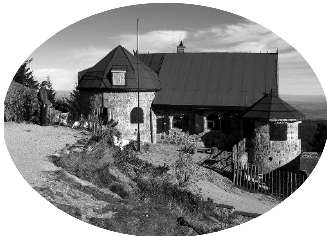
Chata na Vysokém kameni – říjen 2010. Oproti původnímu návrhu byly zastřešeny obě věže.
