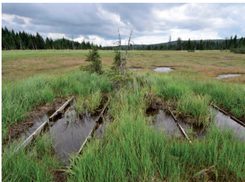
Meliorační rýha s přehrádkami naplněnými vodou na rašeliništi Klugeho louka
