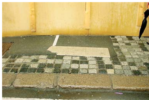
Figur 4-15: Oppmerking av gangfelt og taktile ledelinjer bør være i orden.
