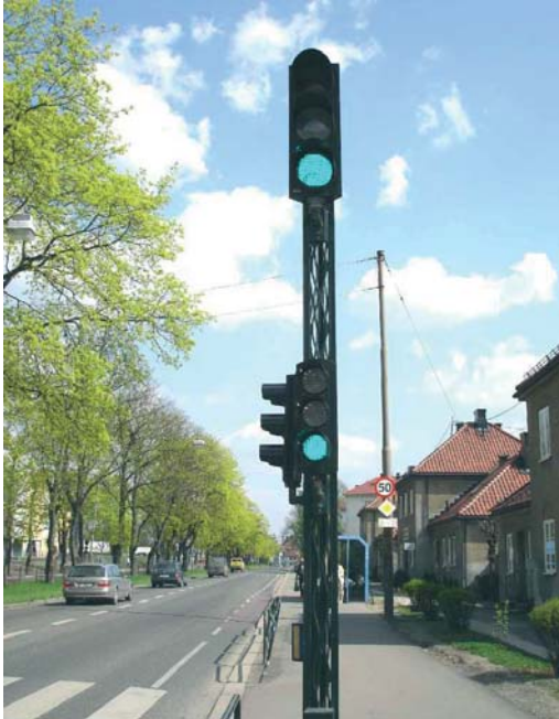
Figur 2-73: Eksempel på gittermast.
