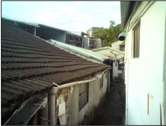
【石角地區芝玉路岩山新村邊垂的違建眷村】
