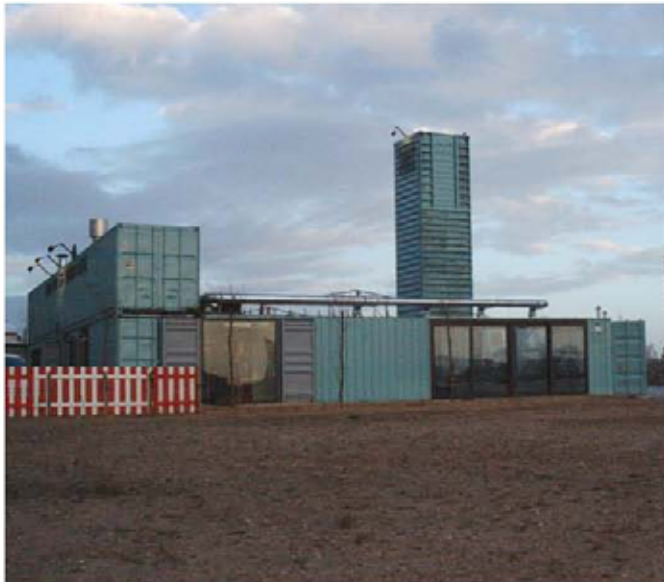
Referentie sober – zakelijk gebouw (zeecontainers)
