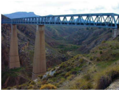
Puente del ferrocarril sobre Arroyo Salado de Jódar
