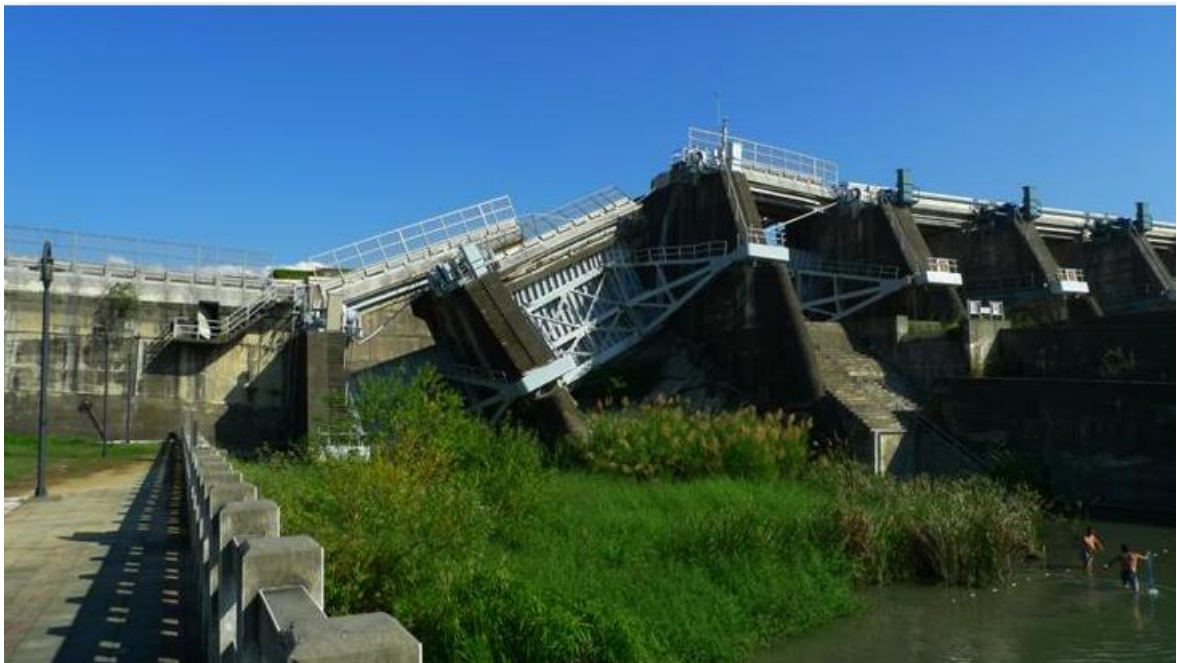
圖 2-3 921 地震石岡壩北側第 15~18 道閘門因地表破裂錯斷圖
