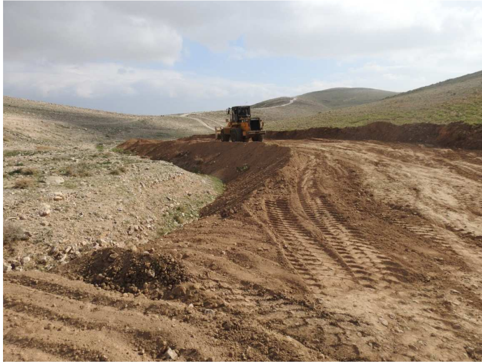
أثناء شق طريق في بلدة زعترة
