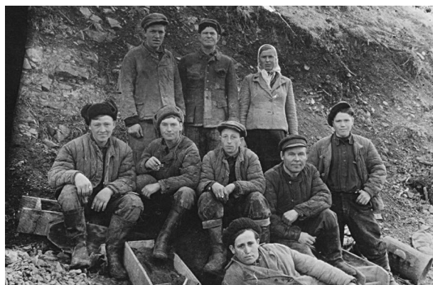
На восстановлении гидравлики в п. Боровское
