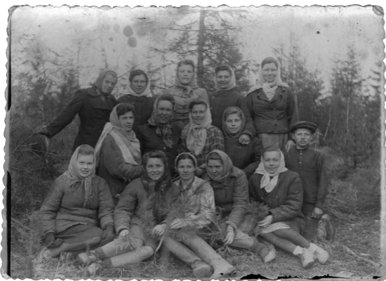
На строительстве завода в п. Тёплая гора. В 1-м ряду справа - Г.И. Лавринок
