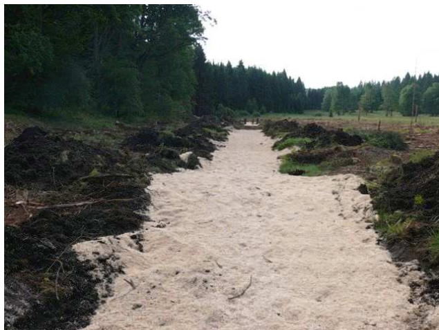
Abb. 5: Kahlschlag und Grabenverschluss mit der „Zuger Methoden“ auf den „Teichwiesen“. Von links nach rechts und von oben nach unten:
