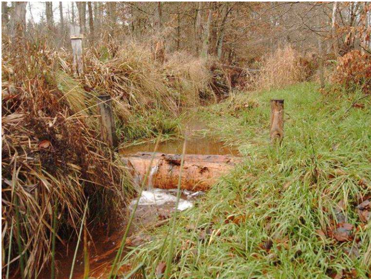
Abb. 29: Sohlschwelle 9 im Sudwalder Graben am 25.11.2003 bei sehr niedriger Wasserführung.
