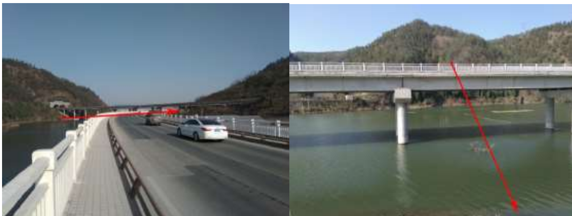
DK253+194.0 处跨越沙州大桥（箭头指向大里程）
