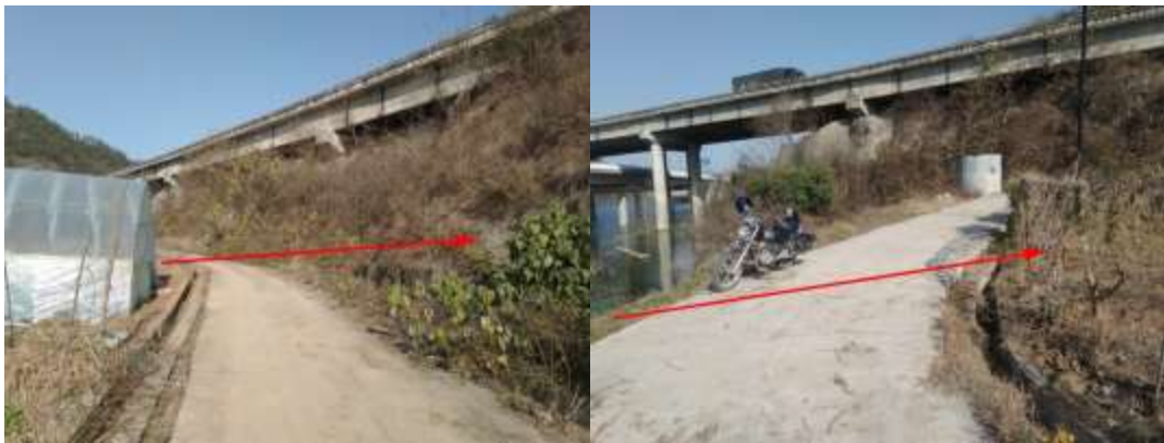
跨越处路、渠（箭头指向大里程）
