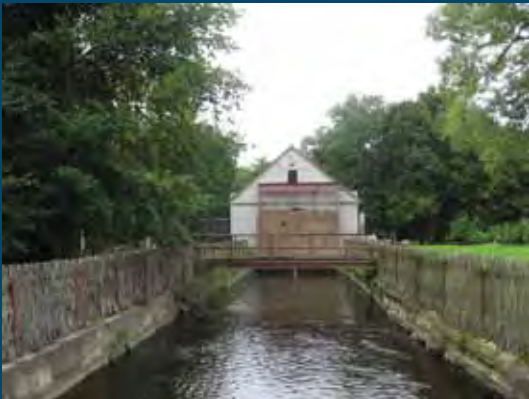
Atitekėjimo kanalas ir HE pastatas Water inlet canal and powerhouse
