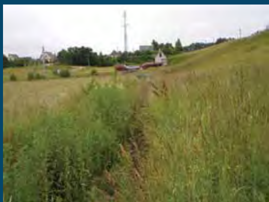
HE užtvankos papėdėje Hydropower plant at the foot of the dam
