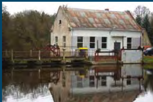
HE pastatas iš tvenkinio pusės Powerhouse from reservoir side
