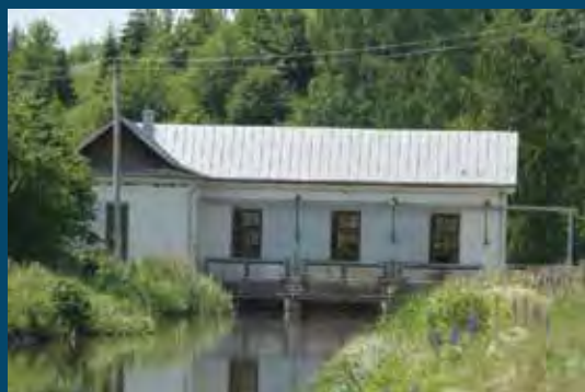
HE pastatas iš derivacinio kanalo pusės Powerhouse from diversion canal side
