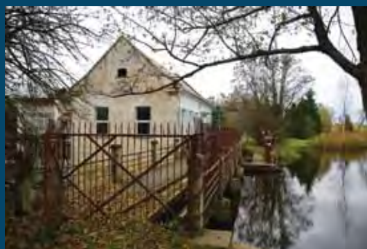
Betoninė užtvanka su greta esančiu HE pastatu Concrete dam with powerhouse
