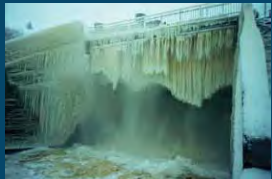
Betoninė užtvanka žiemą Concrete overflow spillway in winter
