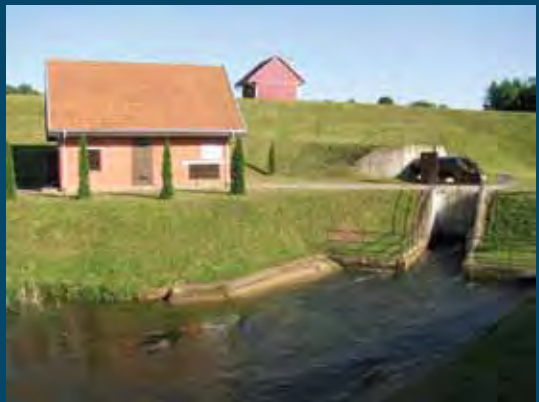
Naujai pastatytų statinių kompleksas Newly build hydro scheme elements
