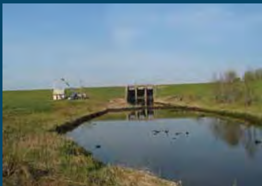
HE, žemių užtvanka ir betoninė užtvanka Hydropower plant, earthfill dam and concrete overflow spillway
