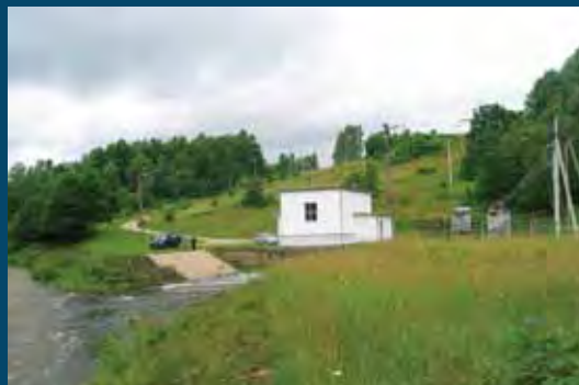
HE pastatas ir nutekėjimo dalis Powerhouse and water outlet
