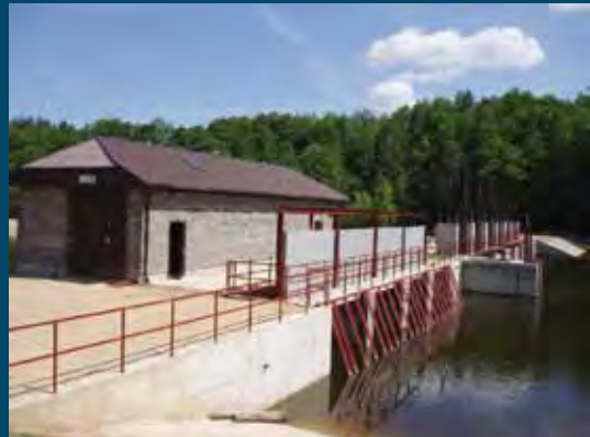
HE pastatas iš tvenkinio pusės Powerhouse from reservoir side
