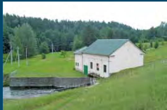
HE pastatas užtvankos papėdėje Powerhouse at the foot of the dam
