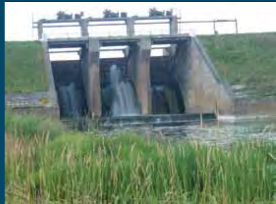
Slenkstinė betoninė užtvanka Concrete overflow spillway
