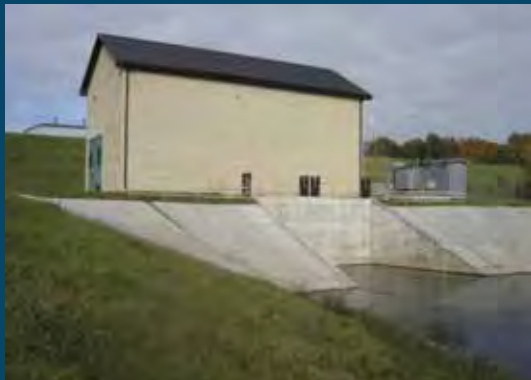
HE pastatas iš nutekėjimo dalies pusės Powerhouse from water outlet side
