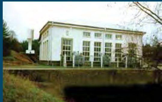
HE pastatas iš nutekėjimo kanalo pusės Powerhouse from outlet canal side
