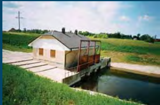
HE pastatas iš nutekėjimo kanalo pusės Powerhouse from water outlet canal
