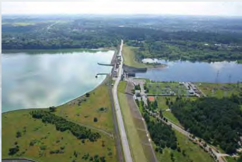
Kauno HE marios (kairėje) ir užtvanka Kaunas HP reservoir (L) and earthfill dam
