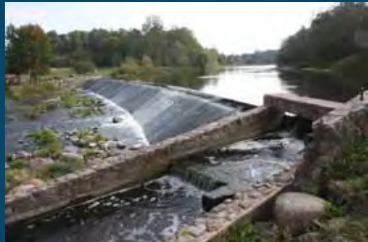
Slenkstinė užtvanka ir žuvitakis Overflow spillway and fish ladder
