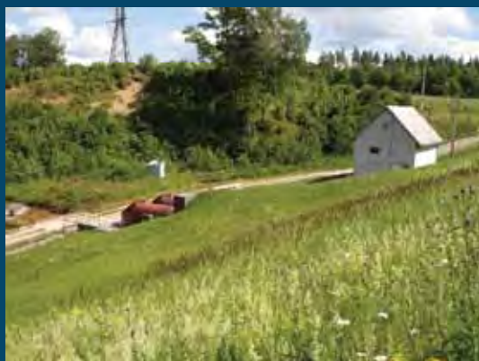
HE nuo žemių užtvankos viršaus Hydropower plant from the top of earthfill dam
