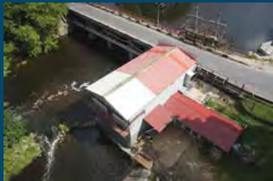
HE pastatas ir betoninė užtvanka Powerhouse and concrete dam
