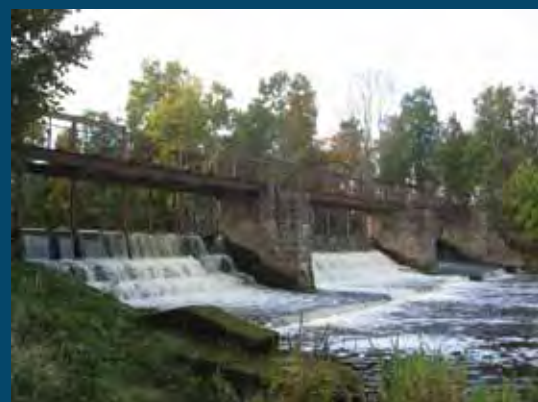
Slenkstinė betoninė užtvanka Concrete overflow spillway
