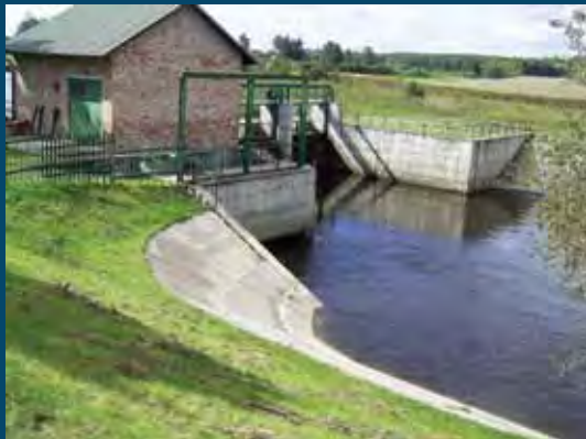
HE pastatas iš nutekėjimo dalies pusės Powerhouse from water outlet side
