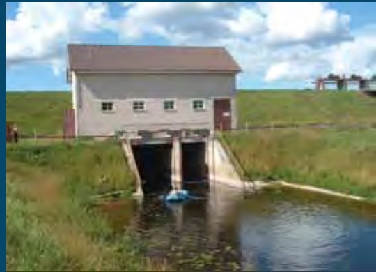
HE pastatas iš nutekėjimo kanalo pusės Powerhouse from outlet canal side
