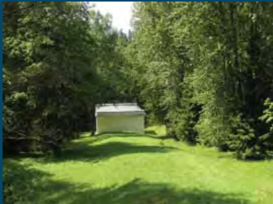
HE pastatas užtvankos papėdėje Powerhouse at the foot of the dam
