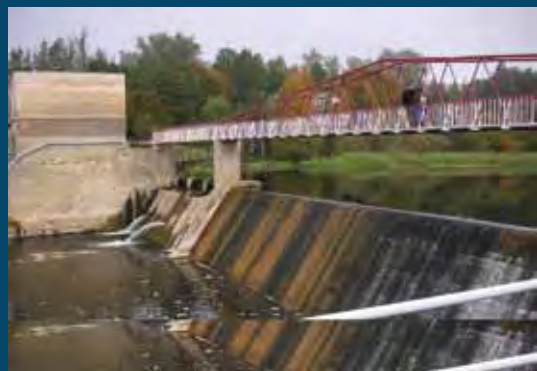
Slenkstinė betoninė užtvanka Concrete overflow spillway
