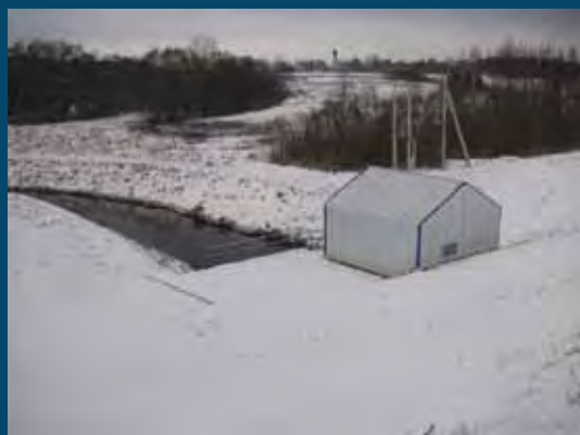
HE pastatas ir nutekėjimo dalis Powerhouse and water outlet
