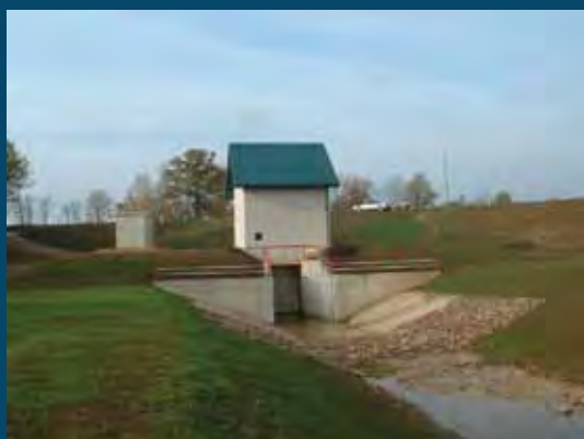
HE pastatas iš nutekėjimo kanalo pusės Powerhouse from water outlet canal
