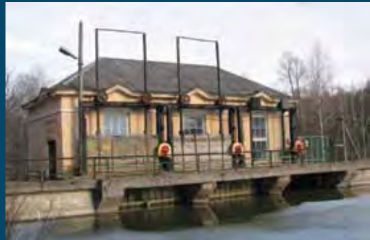
HE pastatas iš tvenkinio pusės Powerhouse from reservoir side
