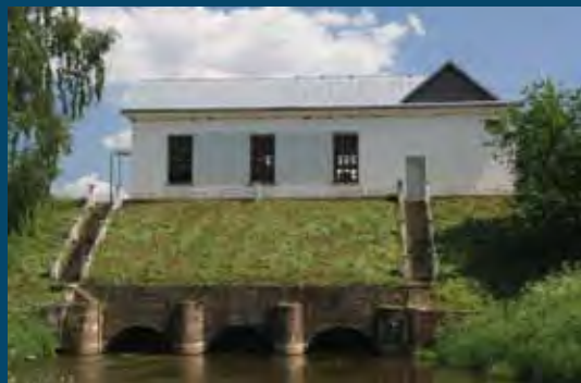
HE pastatas iš nutekėjimo kanalo pusės Powerhouse from water outlet side
