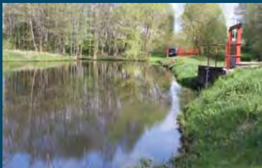
HE ištekėjimo dalis Water outlet structure
