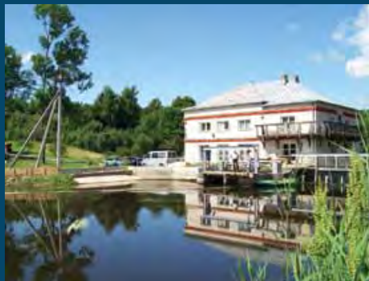
HE pastatas iš tvenkinio pusės Powerhouse from reservoir side
