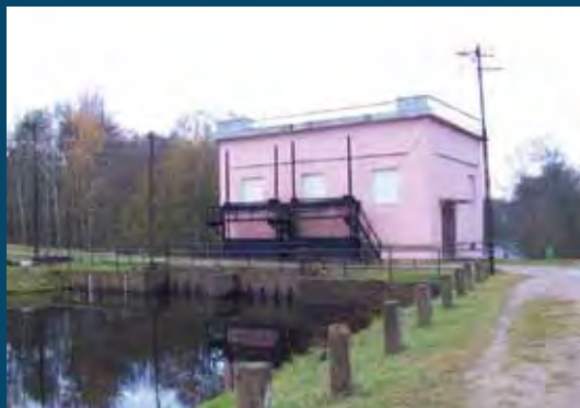
HE pastatas iš tvenkinio pusės Powerhouse from reservoir side
