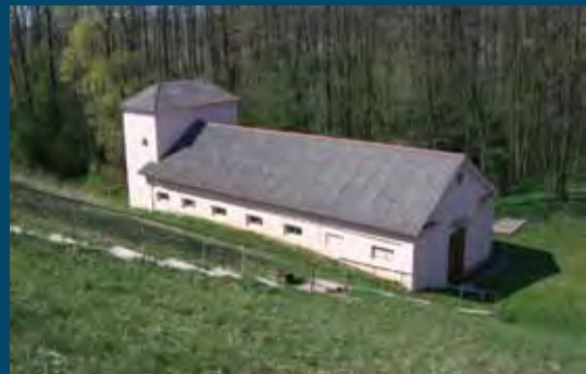
HE pastatas užtvankos papėdėje Powerhouse at the foot of the dam
