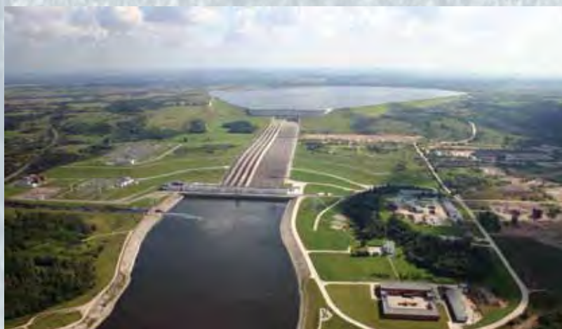
Kruonio HAE viršutinis baseinas, keturi slėginiai vamzdžiai ir žemutinis baseinas (Kauno HE marios)
