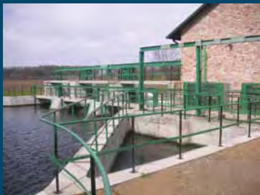
Betoninė užtvanka su greta esančiu HE pastatu Concrete dam with powerhouse
