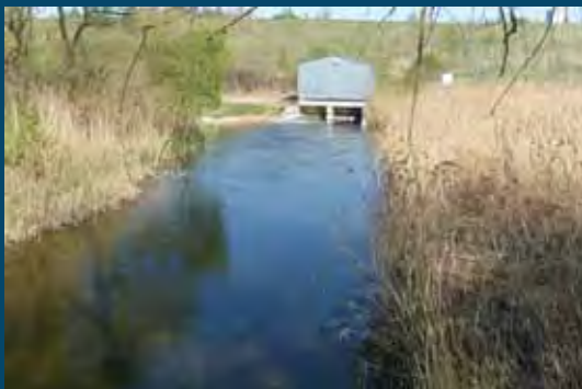
HE pastatas iš nutekėjimo dalies pusės Powerhouse from water outlet side
