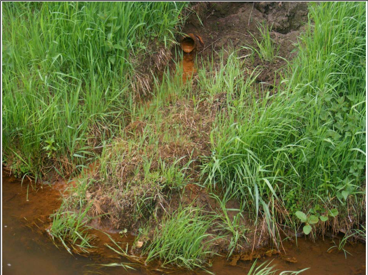
Foto 9 - Delme - Oberlauf/WK 23025 - unterhalb v. Wasserzug hinter den Linden: Häufig tragen auch Rohrdränungen Eisenocker ein
