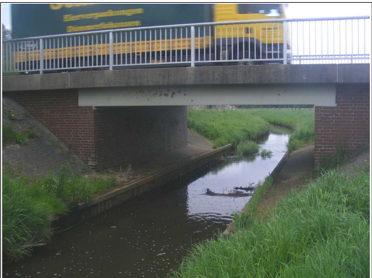
Foto 12 - Delme - Oberlauf/WK 23025 - L341/Gr. Köhren: Ausreichend dimensionierte Brücke mit beidseitiger Berme
