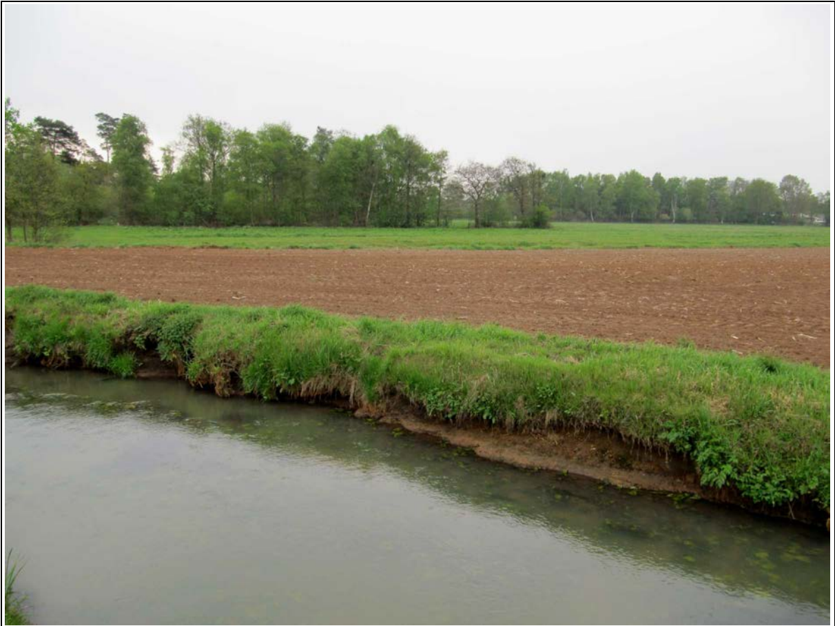
Foto 57 - Delme - Unterlauf/WK 23004 - auf Höhe von Struthafe: Instabile Böschungen bei unmittelbar anliegender Ackernutzung
