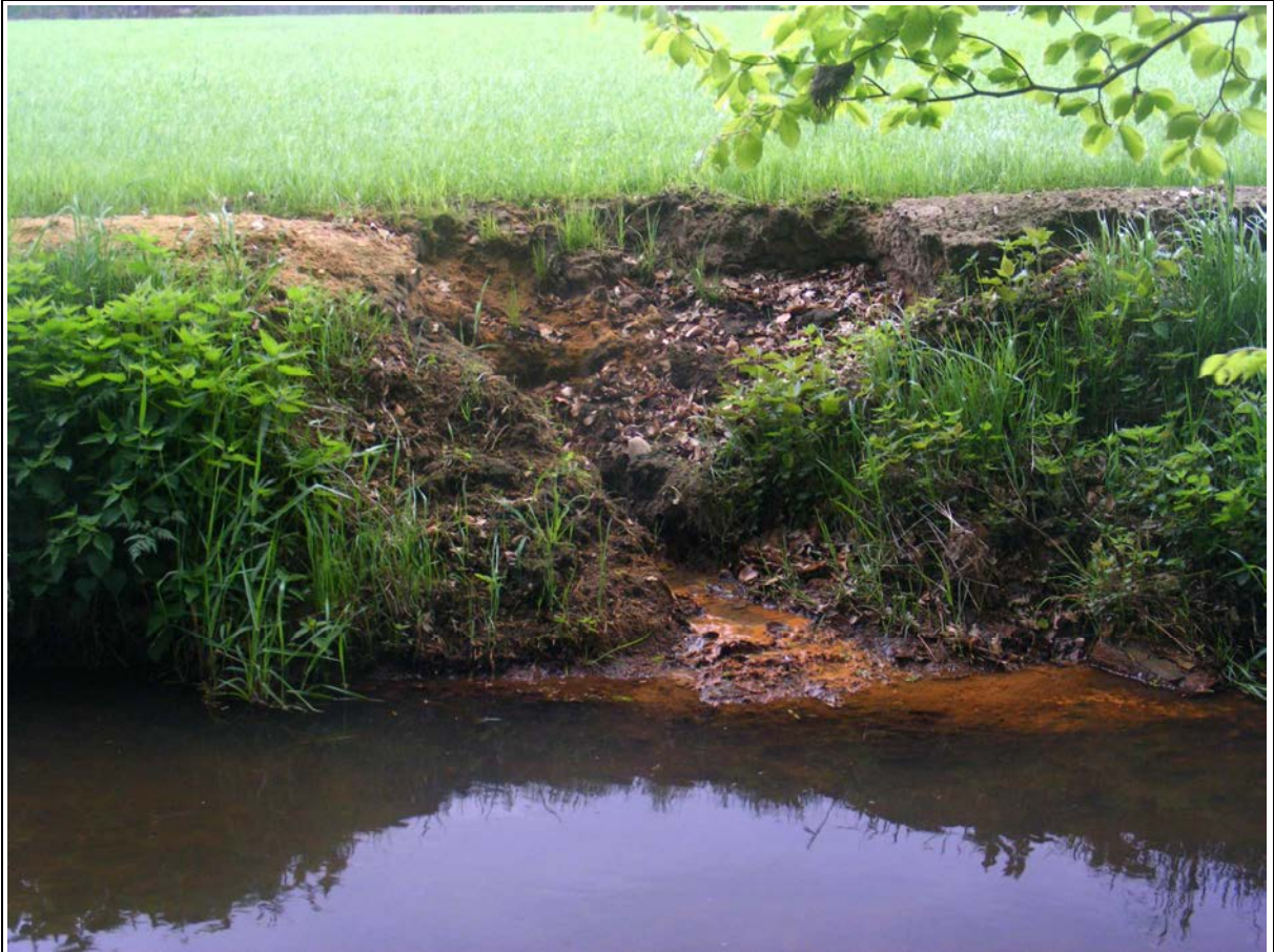
Foto 11 - Delme - Oberlauf/WK 23025 - oberhalb der L341/Gr. Köhren: Die einseitige Uferstabilität verursacht Abbrüche auf der schwächeren und baum- freien Nutzungsseite
