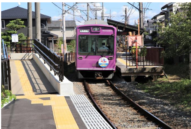
スロープ、点字タイルなどバリアフリー施設（宇多野駅）
