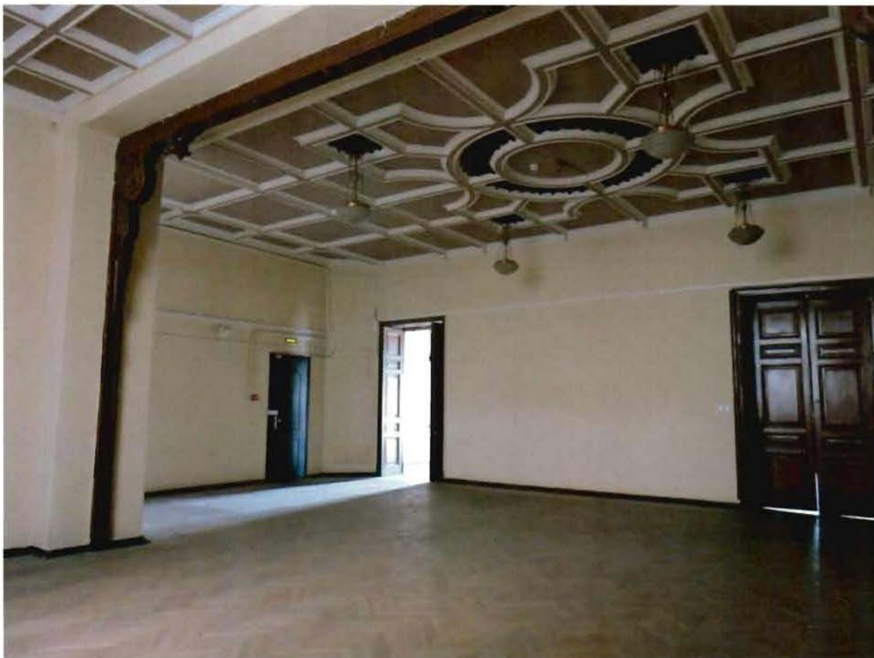
9. Пом. 13Н (34), 2 этаж.
