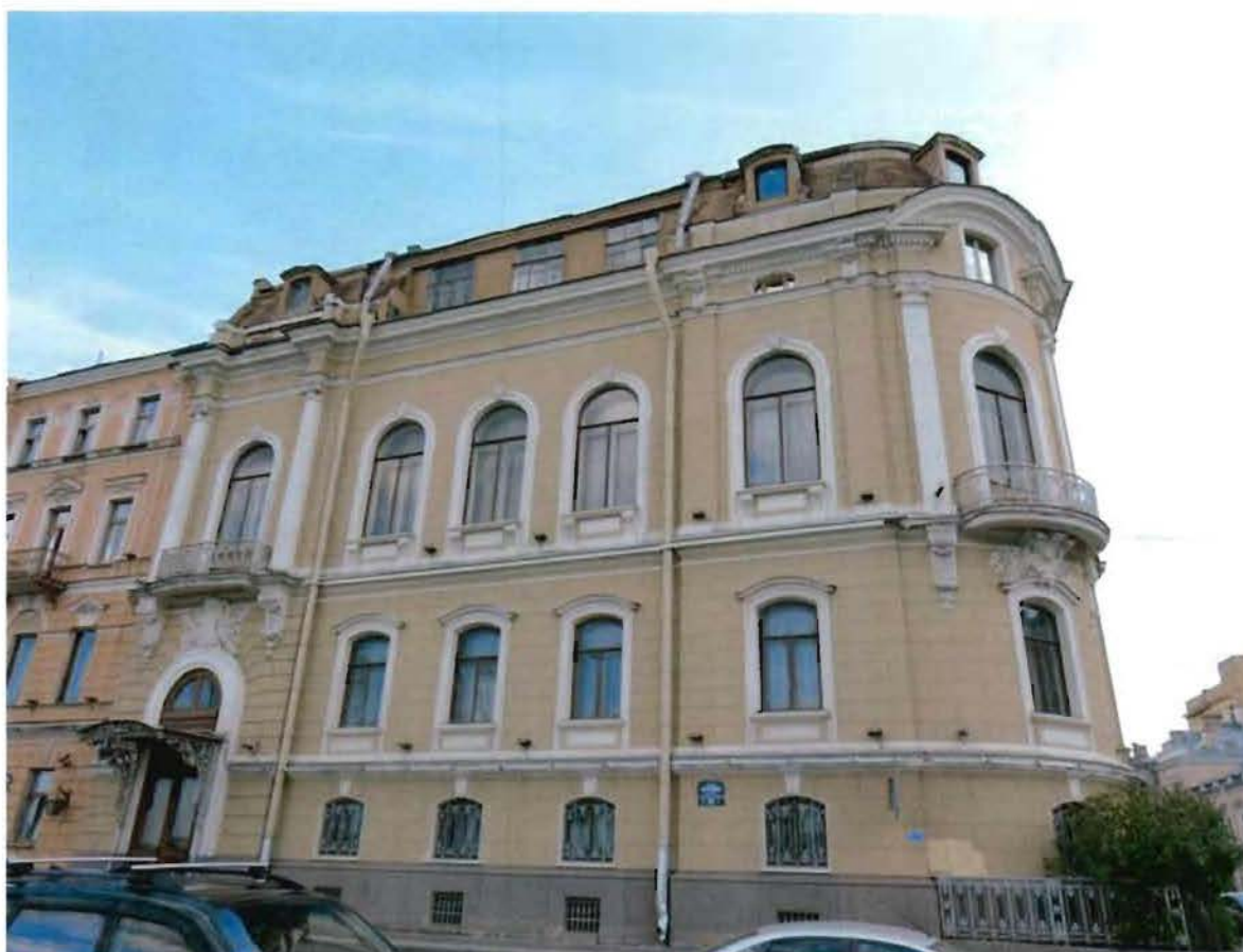
2. Фасад по набережной Кутузова
