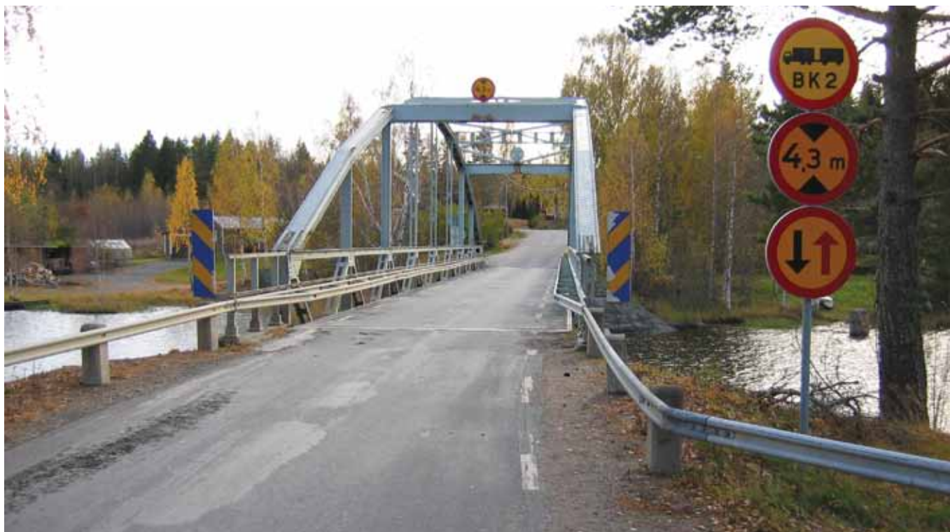
Brobanan vilar på tvärbalkar i underkant av fackverksbalkarna, vilket gör att trafikanterna kan se delar av fackverket vid överfart. Foto: Kulturbyggnadsbyrån, Sven Olof Ahlberg
