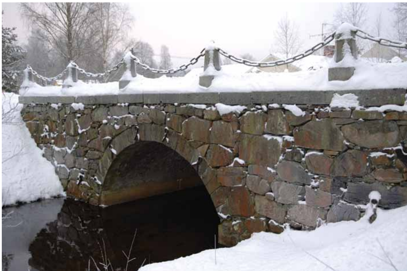
En välgjord stenvälvbro som med bearbetade stengardister och kättingar visar på brons ståndsmässiga läge i den forna parken vid Garpenbergs bruk. Foto: Kulturbymråden, Sven Olof Ahlberg
