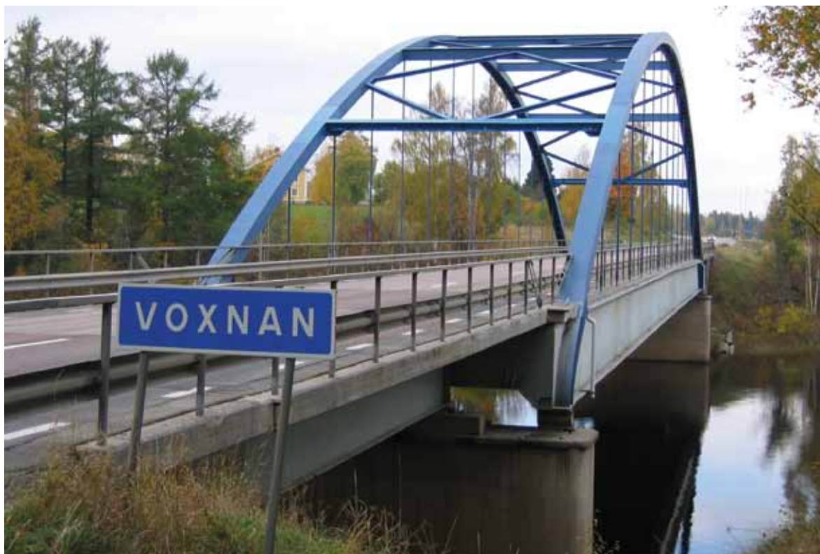
Huvudspannet är upplagt på leder och rulllager som medger längdförändring i takt med att temperaturen växlar. Foto: Kulturbyggnadsbyrån, Sven Olof Ahlberg
