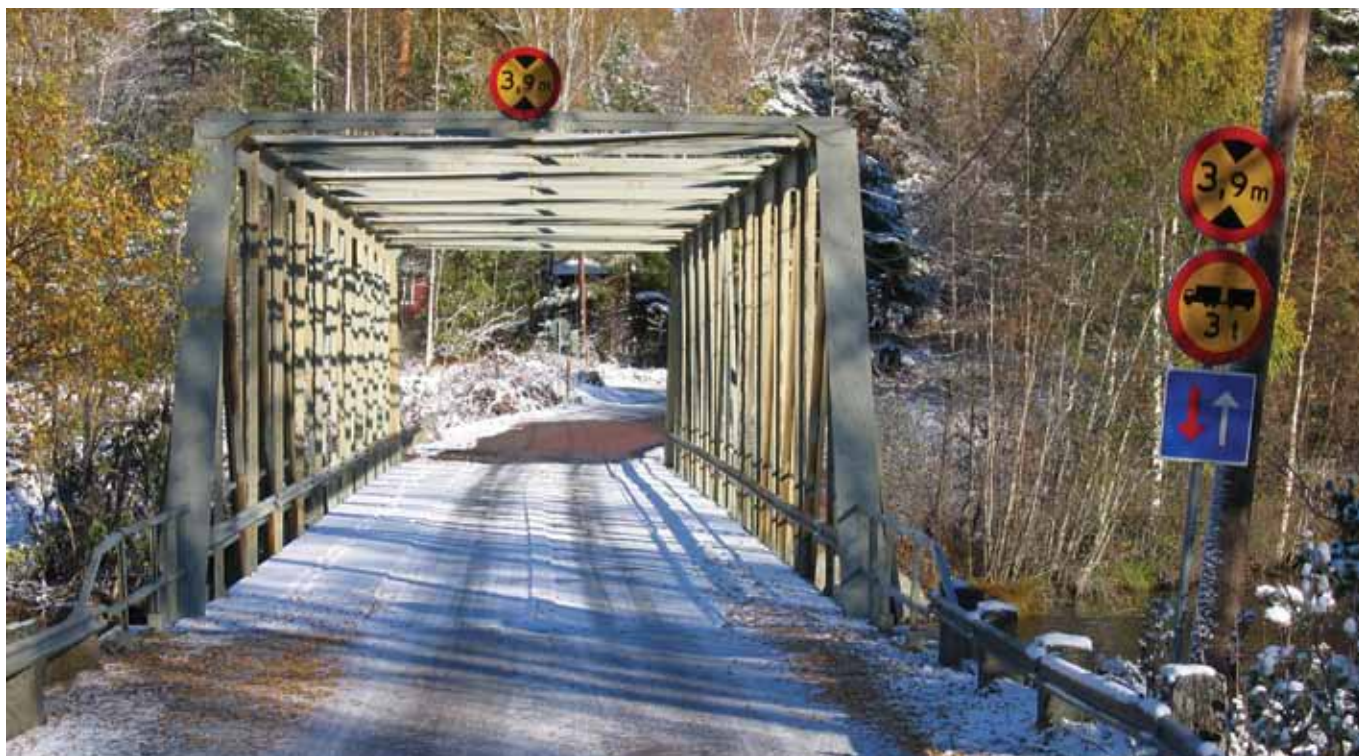
Ändvy av bron vid Norsbro. För trafikanter som passerar över bron kan fackverket upplevas som en tunnel av stänger och stag som effektivt ramar in den ålderdomliga brobanan av träplank. Foto: Kulturbyggnadsbyrån, Sven Olof Ahlberg
