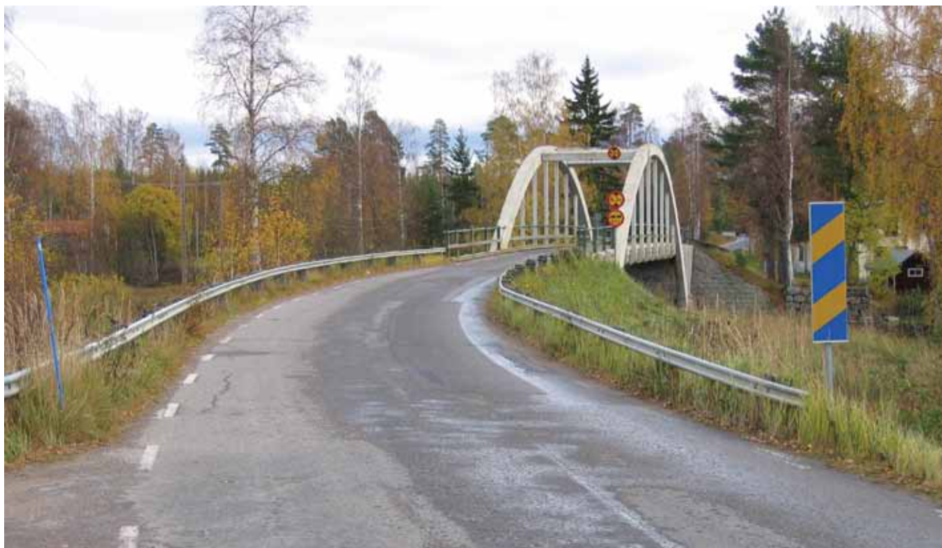
Trafikanterna möter Norrbobron via kurvor från båda håll. En tilltalande vägsträckning som gör det möjligt att observera både bron och hindret innan överfart. Foto: Kulturbyggnadsbyrån, Sven Olof Ahlberg
