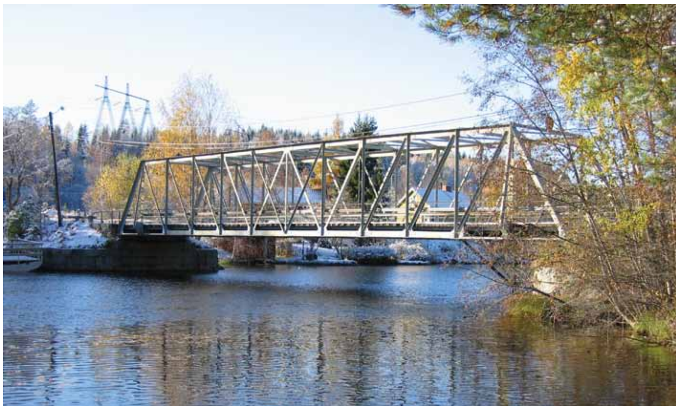
Det luftiga stålfackverket i bron vid Norsbro överbryggar sundet på ett elegant vis där vertikaler och diagonaler upprepas på ett intrikat och spännande sätt. Foto: Kulturbymråden, Sven Olof Ahlberg
