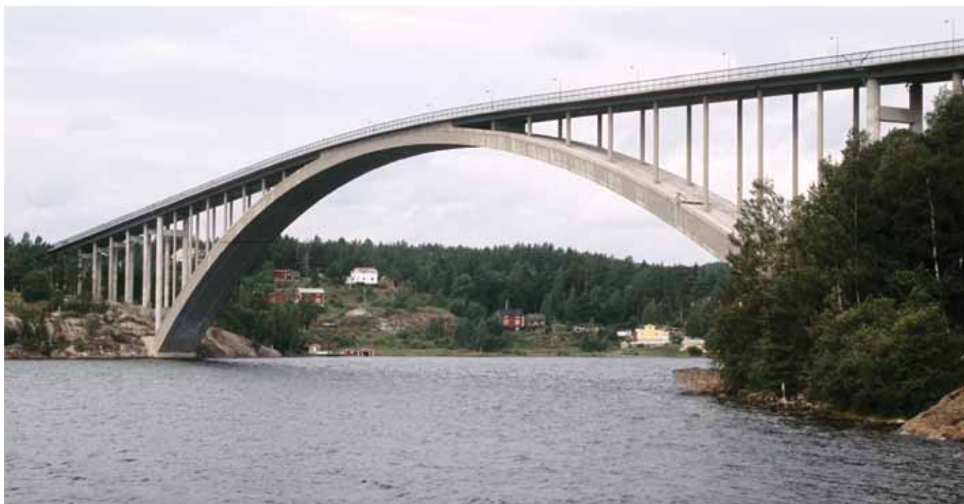
Sandöbron efter renoveringen i slutet på 1990-talet. Bilden är tagen från Sandön och visar brobanans tydliga puckelform. Foto: Kulturbyggnadsbyrån, Sven Olof Ahlberg
