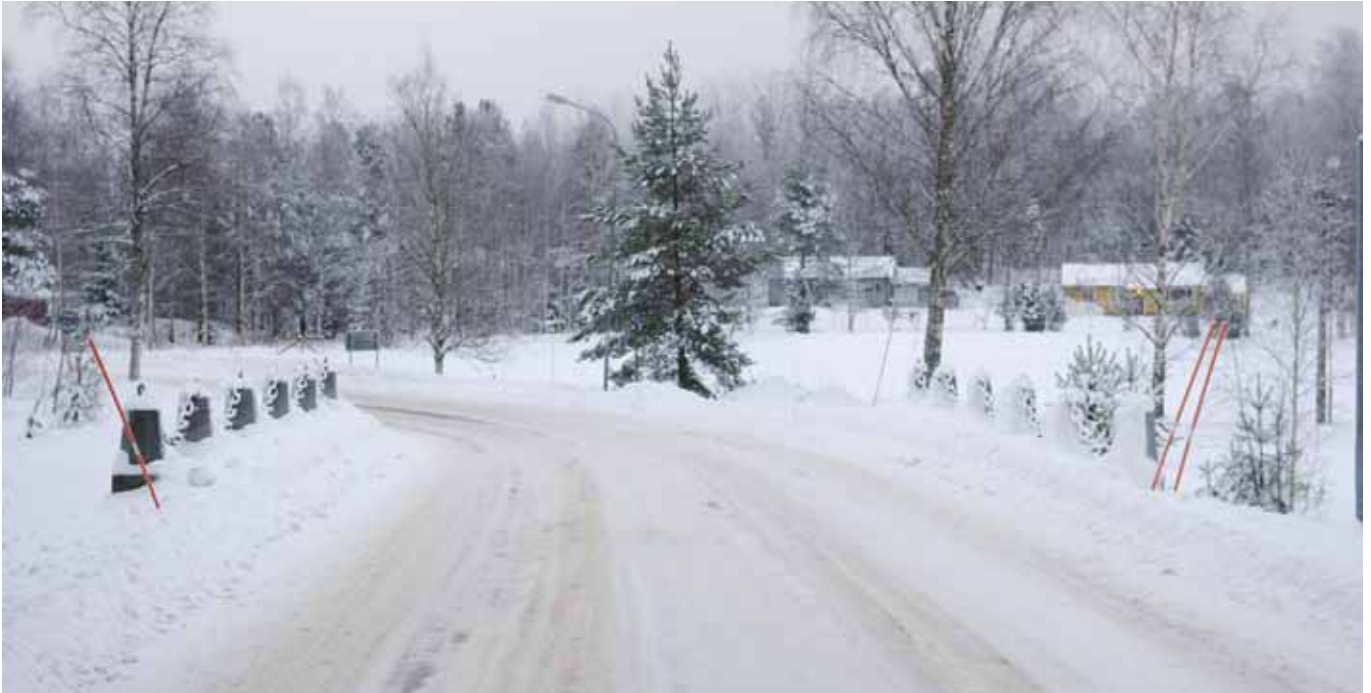
En bred brobana som inramas av kraftfulla stengardister möter trafikanterna över bron i Garpenberg. Arrangemanget med kättingar som enda räcke är unikt för det allmänna vägnätet. Foto: Kulturbyggnadsbyrå, Sven Olof Ahlberg
