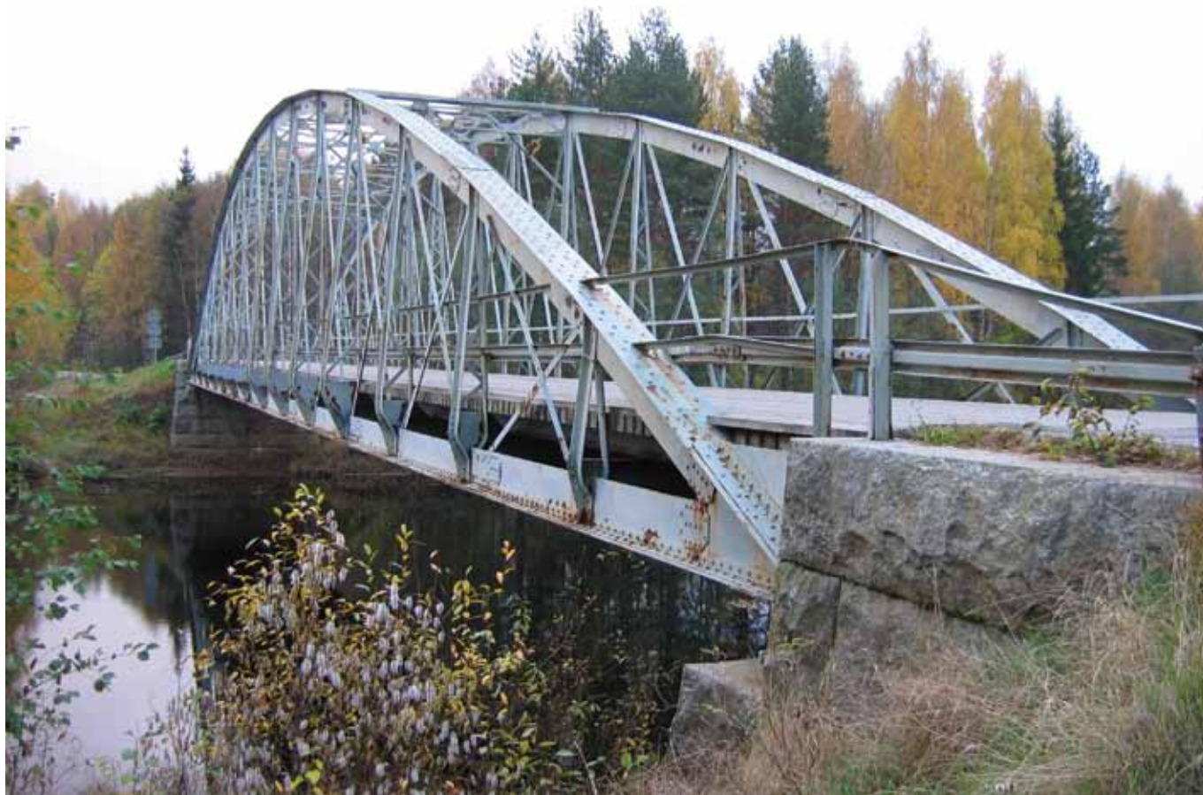
En svensk broklassiker med stående parabelformade fackverksbalkar som utgör ett påtagligt inslag i miljön längs Voxnan. Foto: Kulturbymråden, Sven Olof Ahlberg
