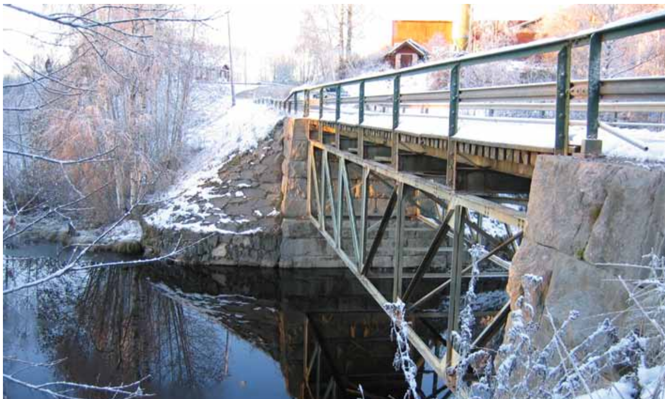
Bärverket vilar på välgjorda och imponerande landfästen av huggen granit. Foto: Kulturbyggnadsbyrå, Sven Olof Ahlberg
