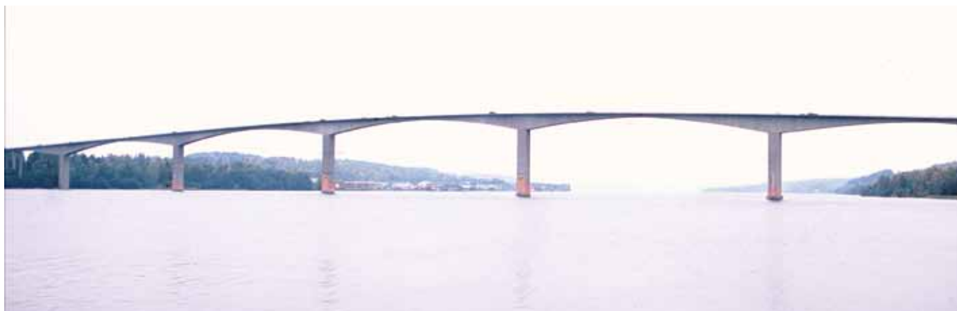
Alnöbron betraktas föreslagsvis på en brolängds avstånd där konstruktionens form kommer bäst till sin rätt. Foto: Kulturbyggnadsbyrån, Sven Olof Ahlberg
