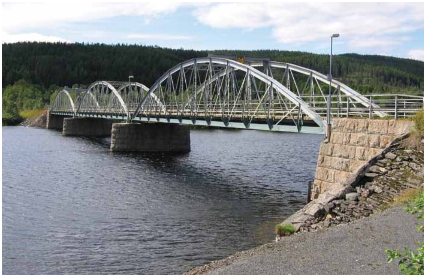
Landets mest harmoniska och vackrast belägna fackverksbro med parabelformade balkar på det allmänna vägnätet. Foto: Kulturbbyggnadsbyrån, Sven Olof Ahlberg
