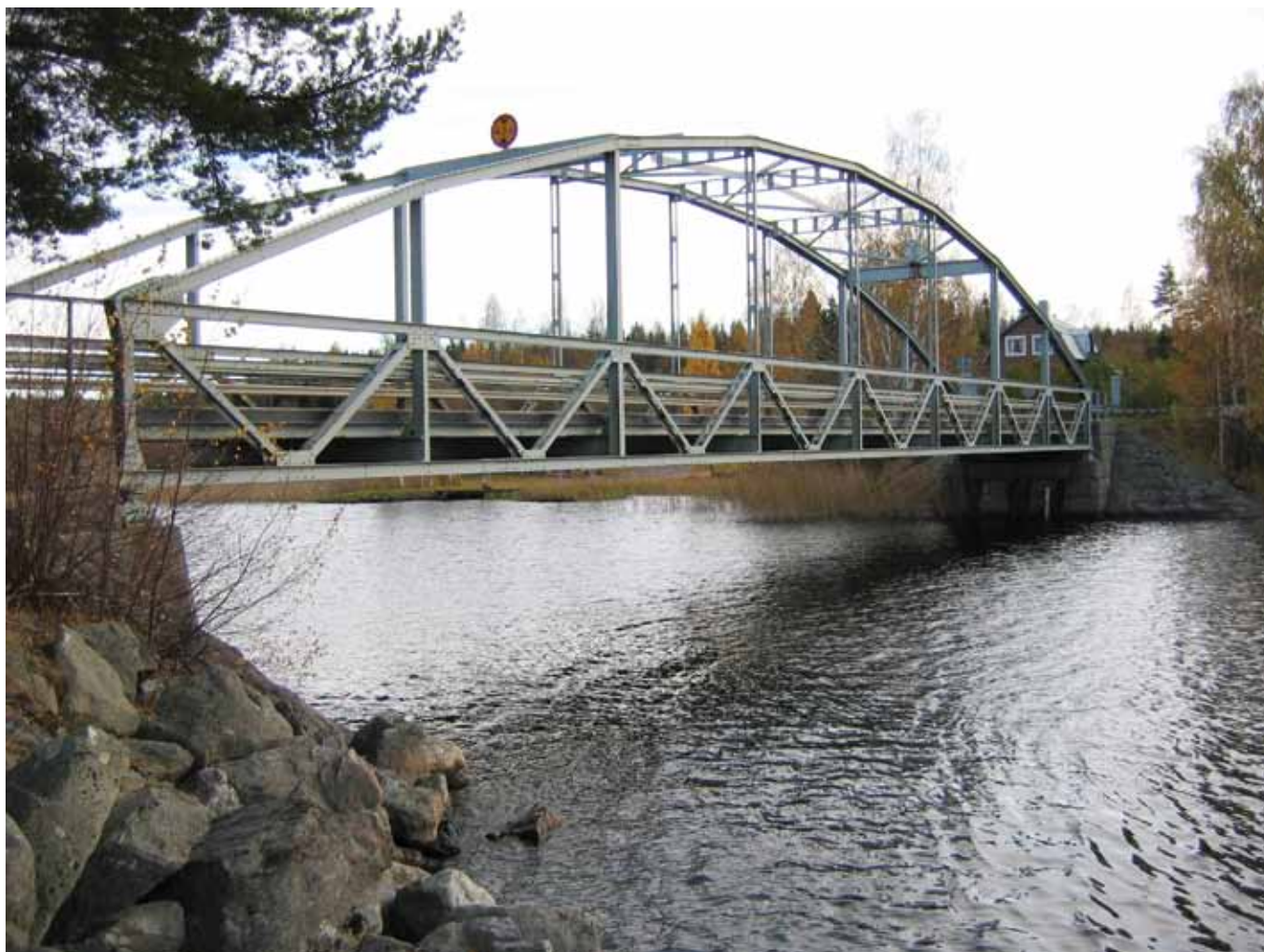
Bärverk av fackverkstyp upphängt i överliggande bågar – en langerbalkbro av klassiskt snitt. Foto: Kulturbyggnadsbyrån, Sven Olof Ahlberg
