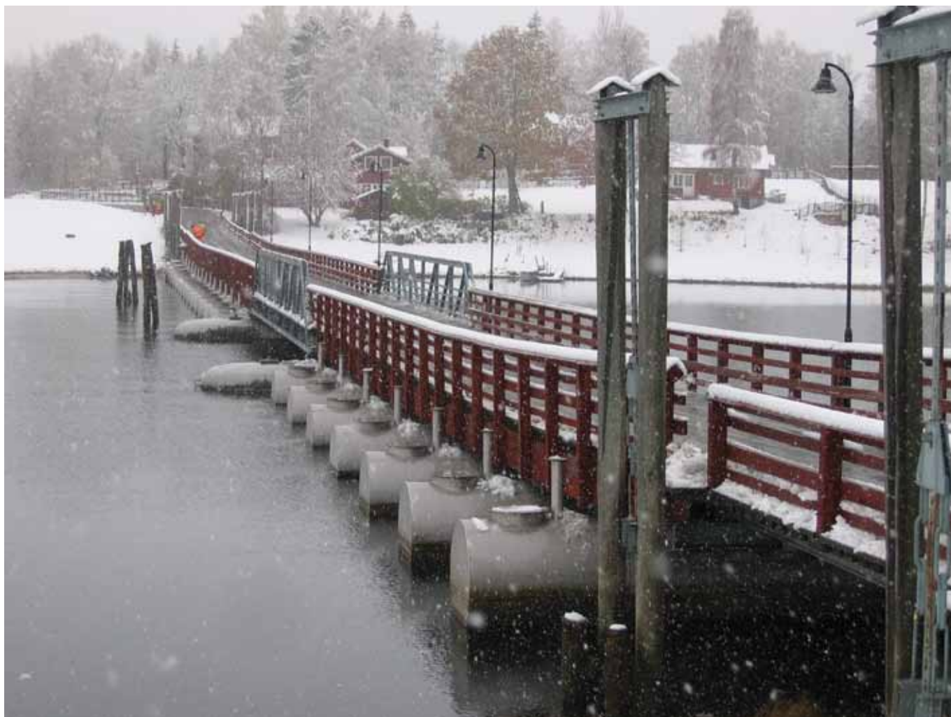
Bron över Dalälven var ursprungligen en flottbro med flytelement av timmer. Idag är det rostfria pontoner som står för bärcraften i konstruktionen. Foto: Kulturbbyggnadsbyrån, Sven Olof Ahlberg
