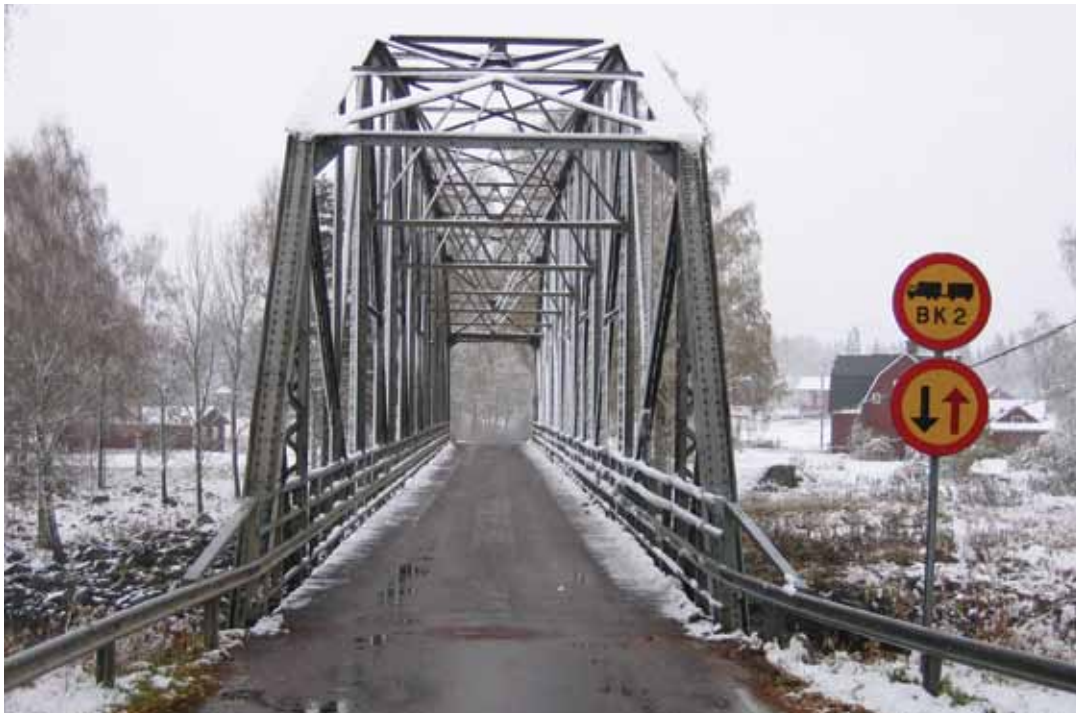
Trafikanterna som färdas över bron passerar genom det jätte "Meccano" som utgör den synliga delen av bärverkets fackverkskonstruktion. Foto: Kulturbyggnadsbyrån, Sven Olof Ahlberg
