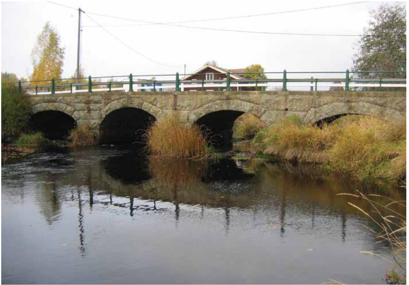
Välhållen stenvälsbro i fyra spann med karaktärsfullt grönmålat räcke. Foto: Kulturbyggnadsbyrån, Sven Olof Ahlberg
