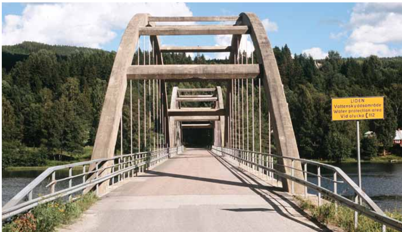
Trafikanternas möte med bron domineras av betongbågarnas mjuka linjespel och de slanka hängstagens rytmiskt upprepade placering. Foto: Kulturbyggnadsbyrån, Sven Olof Ahlberg
