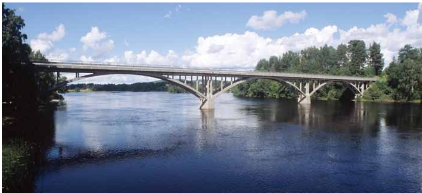
Tre flacka och spänstiga – om än något låga – bågspann överbryggar Ljungan vid Torpshammar i denna bågbro från 1937. Foto: Kulturbymråden, Sven Olof Ahlberg
