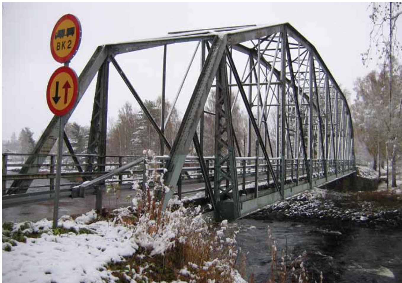
Högrest bärverk med ett virrvarr av strävor, stag och vertikaler karakteriserar bron över Västerdalälven. Foto: Kulturbyggnadsbyrån, Sven Olof Ahlberg
