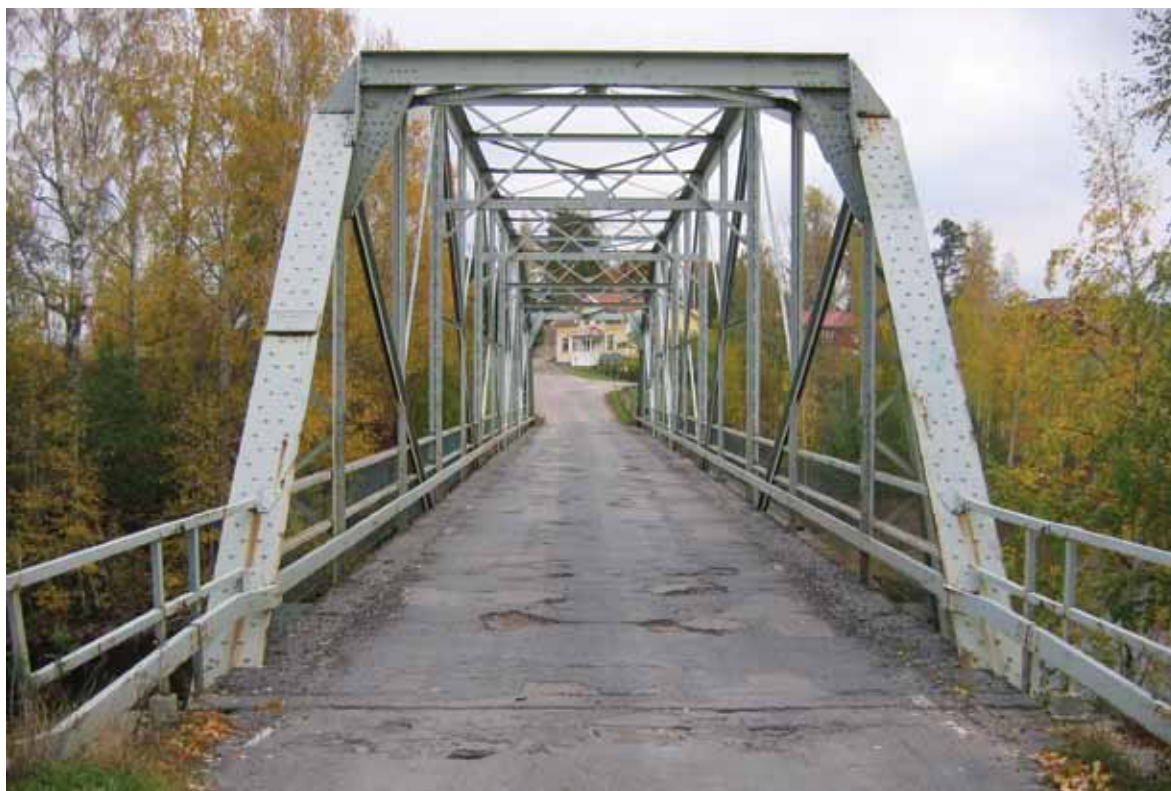
Bron i Lenninge har navföljare av U-profil och räcken med L-profiler – detaljer som numera i allt större grad ersätts med moderna konstruktioner. Foto: Kulturbymråden, Sven Olof Ahlberg
