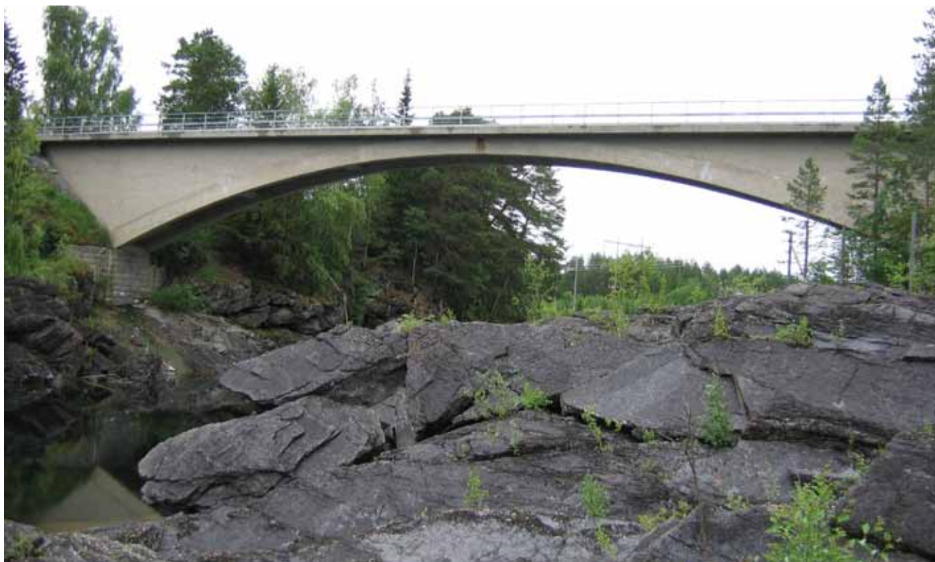
Bågskivebron över Indalsälven har flacka valvbågar som är inspända mellan bergsidorna på båda sidor om forsen. De eleganta formerna är svåra att betrakta på grund av den rikliga vegetationen. Foto: Kulturbyggnadsbyrån, Sven Olof Ahlberg
