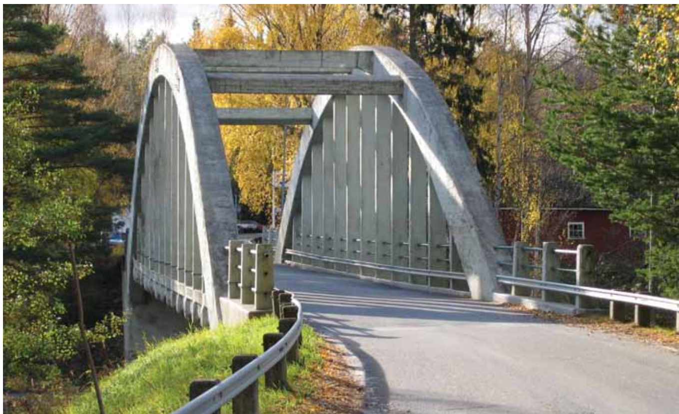
Trafikanterna möts av en imponerande syn vid mötet med bron i Näsvisken. Kraftfulla bågar och hängstag tillsammans med grönmålade gasrörsräcken avslöjar bronns ålder. Foto: Kulturbbyggnadsbyrå, Sven Olof Ahlberg
