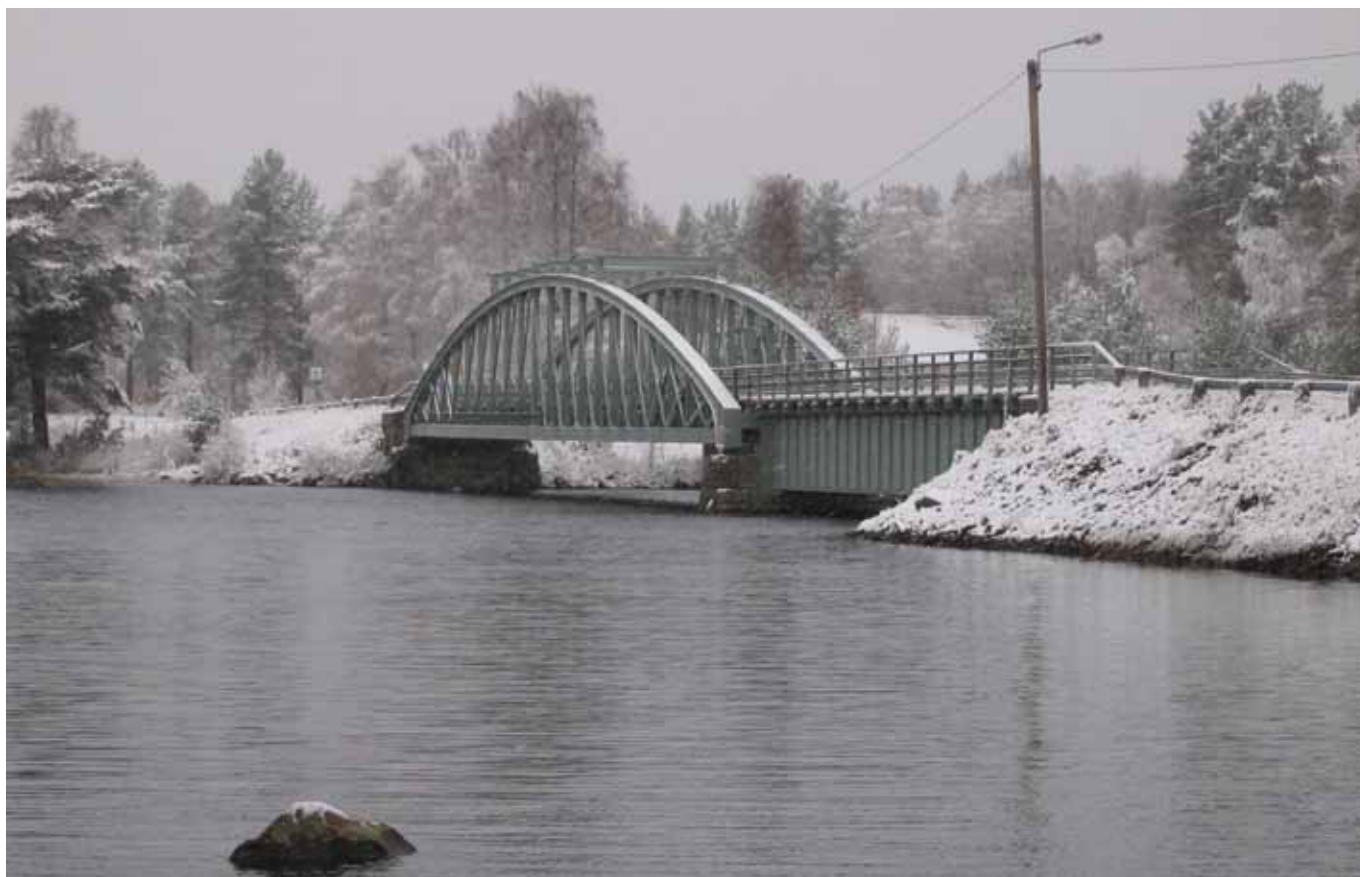
Vägverkets äldsta stålbro uppfördes ursprungligen 1887 som järnvägsbro och betjänar vägtrafiken över Vanån sedan 1919. Foto: Kulturbymråden, Sven Olof Ahlberg
