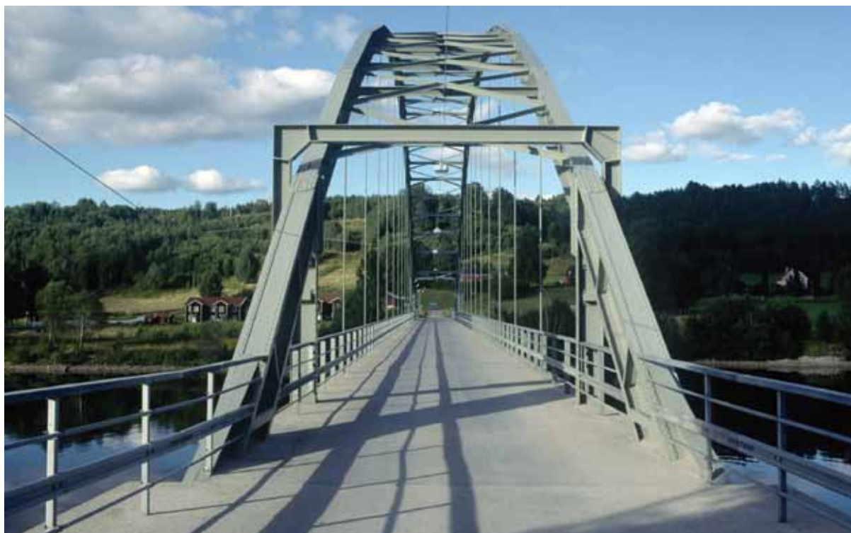
Bågarnas eleganta linjespel störs något av de senare tillkomna påkörningsskydden vid ändtransversalerna. Foto: Kulturbyggnadsbyrån, Sven Olof Ahlberg
