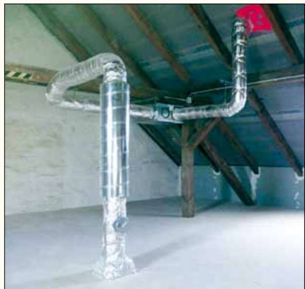
Ringstraße 2/4 · Dachgeschoss - Dämmung und Lüftung
