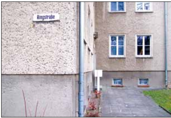
Ringstraße 8 · Fassade – alt
