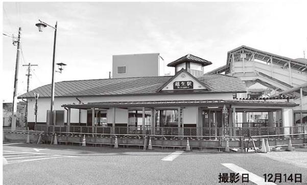
▲越生駅西口 (道灌口)
