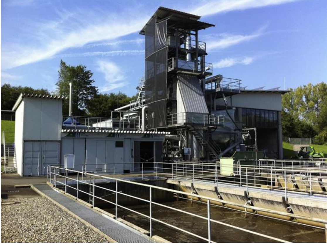
Şekil 4.1 Gazlaştırma tesisi (Almanya) [43]
