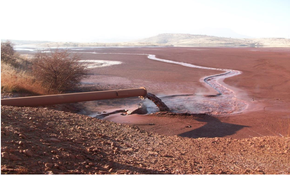
Şekil 3.2. Kırmızı çamur barajı
