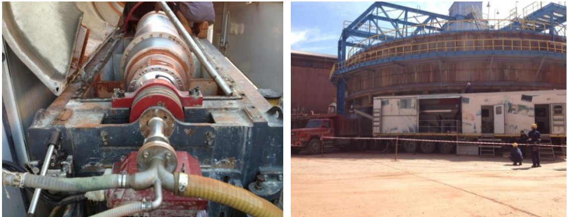
Şekil 6.25. Mobil dekantör santrifüj ünitesi ve 6. yıkayıcı altındaki kurulumu
