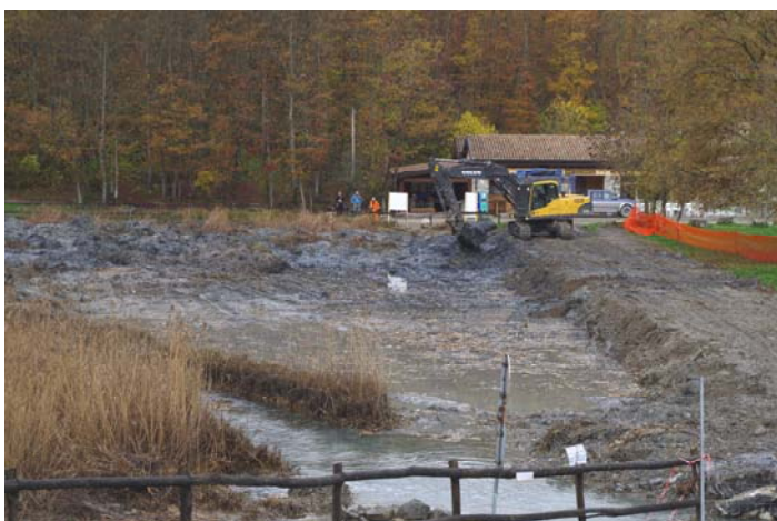
Figura 3. Asportazione dal bacino dei fanghi sedimentati, colonizzati dai rizomi di Phragmites a. (Novembre 2013).
