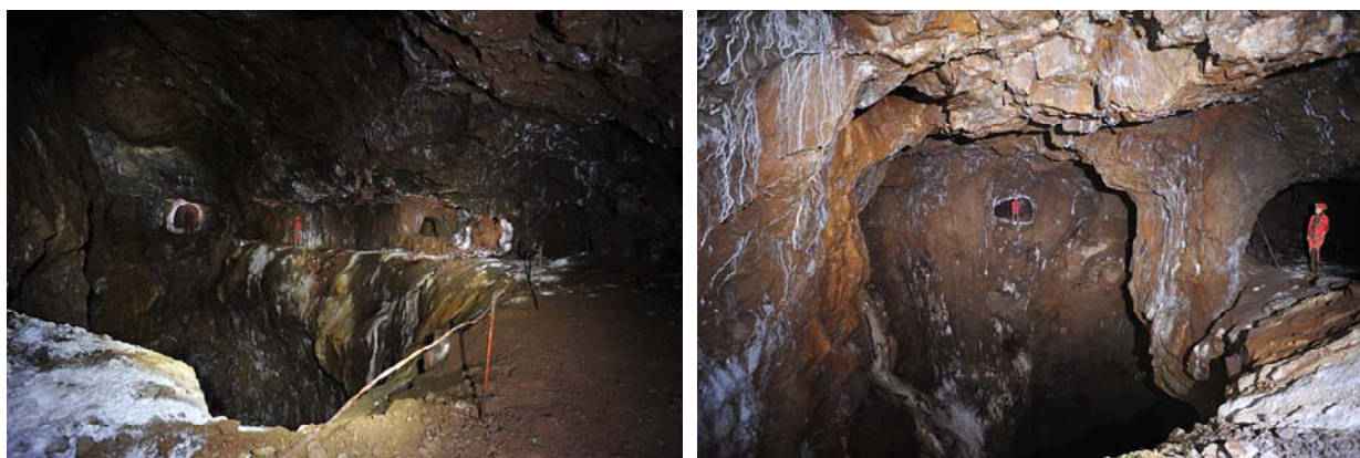
Figura 6. I cantieri del Livello Intermedio (foto .BELVEDERI).
