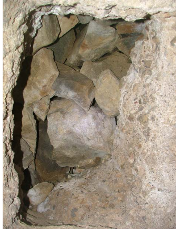
Figura 14. Veduta della struttura a tergo della parete del cunicolo.
