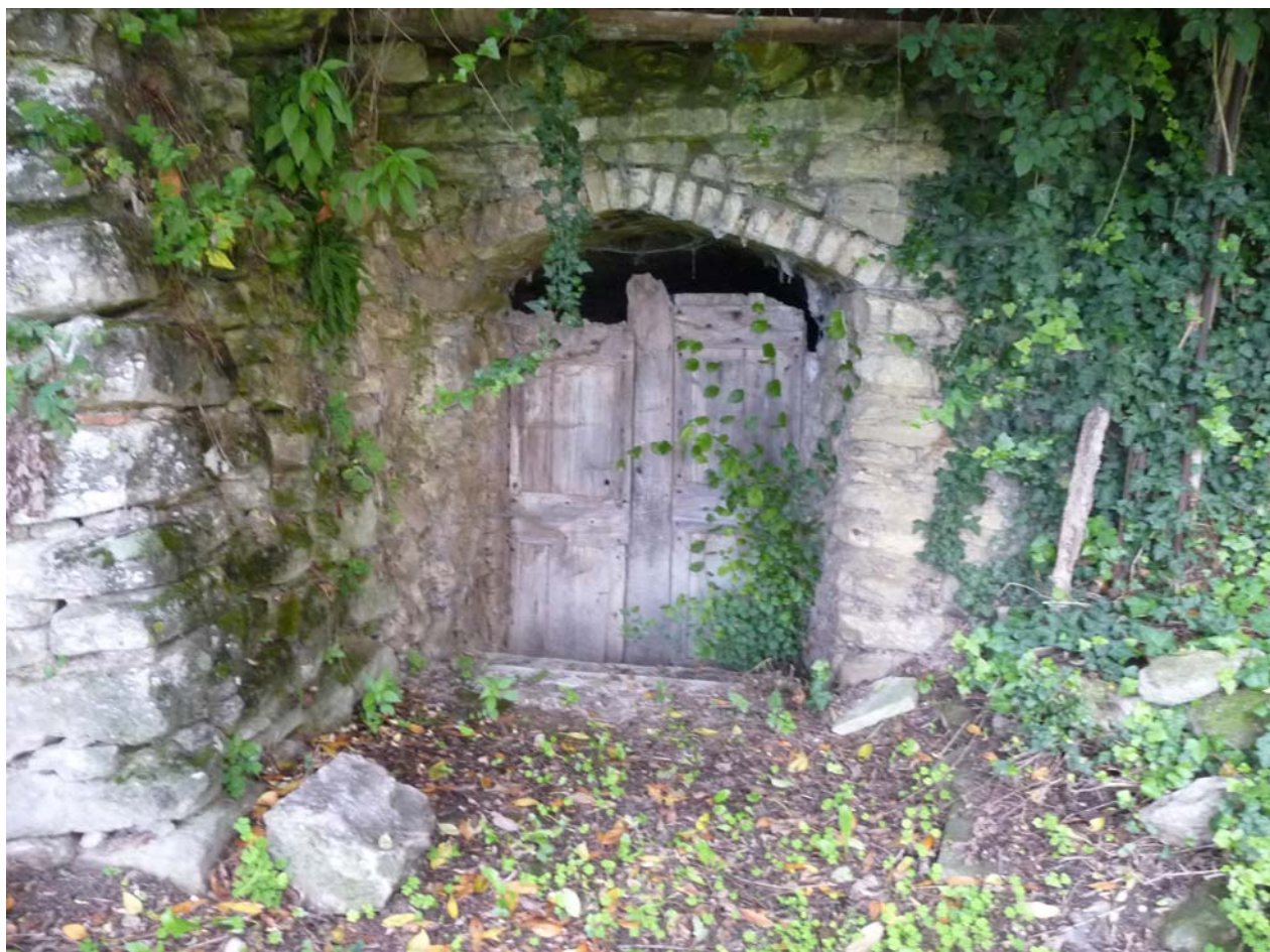
Figura 2. L’ingresso della Grotta Meteorologica o degli Arditi.
