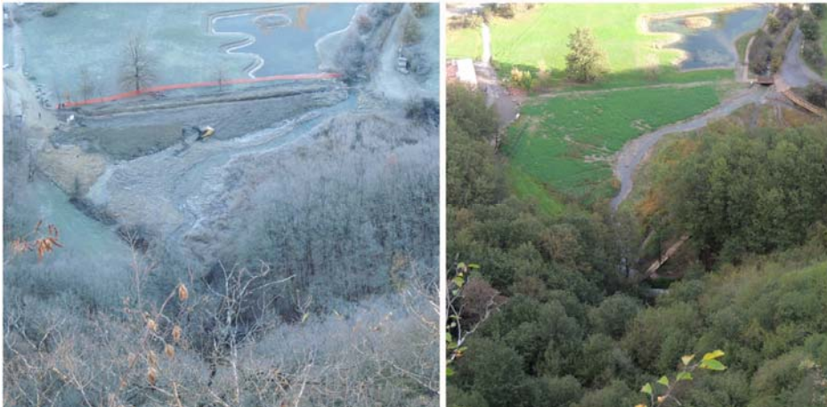
Figura 4. Foto diacronica, dall'alto, dell'area di cantiere (Novembre 2013-Agosto 2014).
