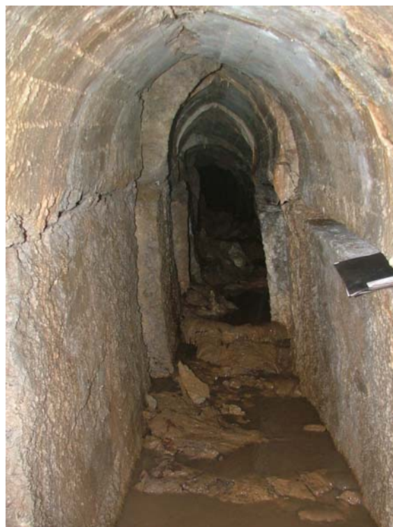
Figura 12. Veduta delle dislocazioni lungo il cunicolo drenante, a monte dello sbocco est.
