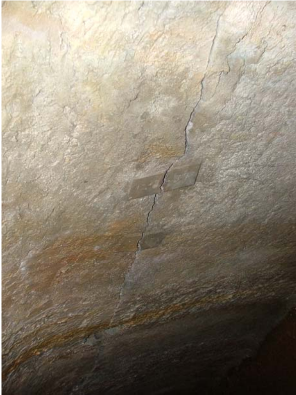
Figura 13. Veduta dei “vetrini artigianali” per il monitoraggio delle dislocazioni, installati il 12 luglio 1937 lungo il tratto occidentale della rete drenante.
