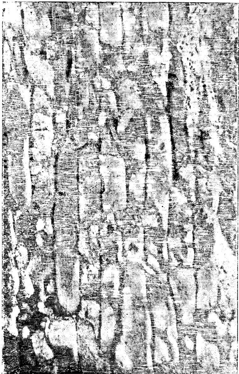
Рис. 8. Внутренняя стена Пятницкой церкви на Малом торгу (Раскопки 1951 г.).
