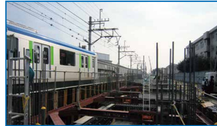
⑥ 野田市駅付近 高架橋建設工事
