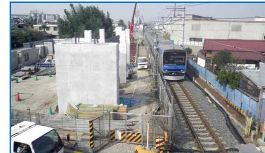
⑦ 野田市～梅郷間 高架橋建設工事
