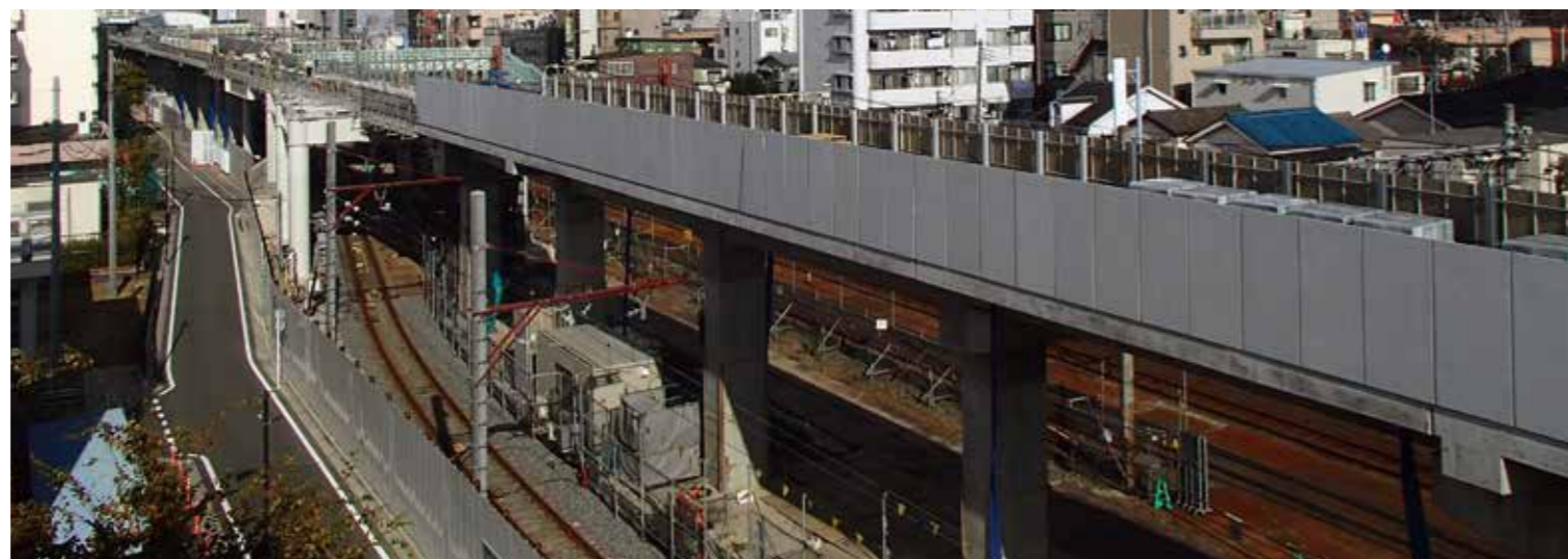
西新井～竹ノ塚間(都営伊興町第2アパート～エミエルタワー付近)高架橋工事進捗状況
