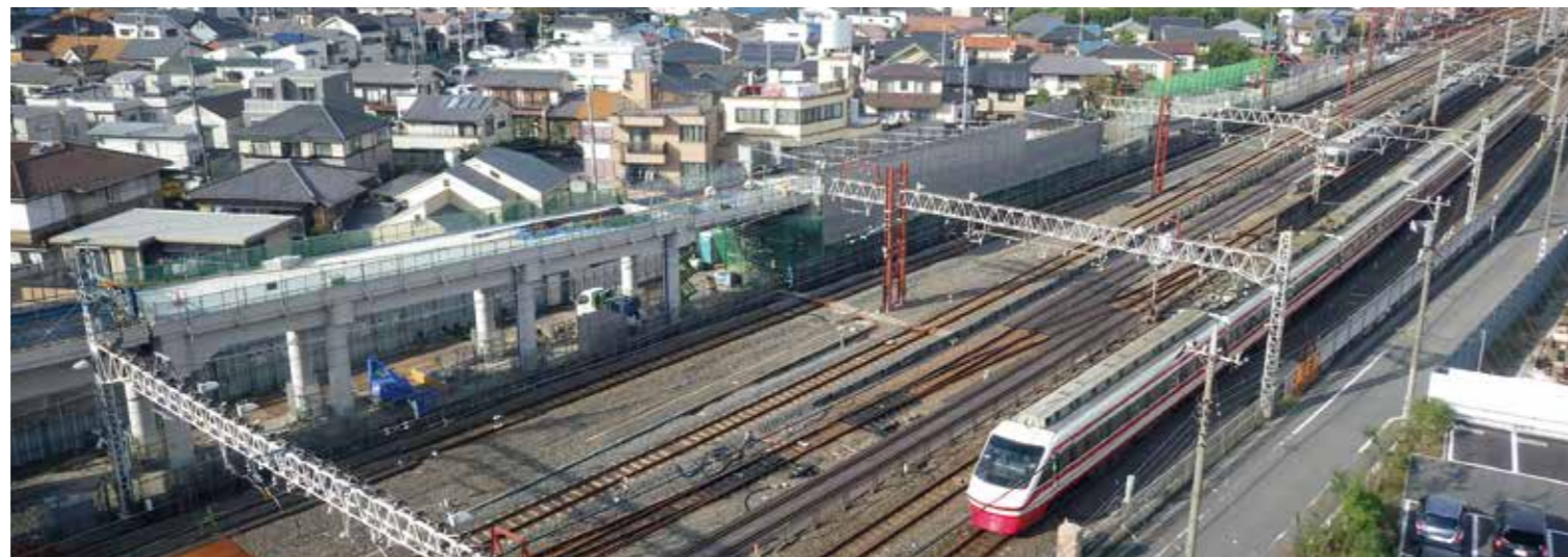
竹ノ塚～谷塚間 高架橋工事進捗状況
