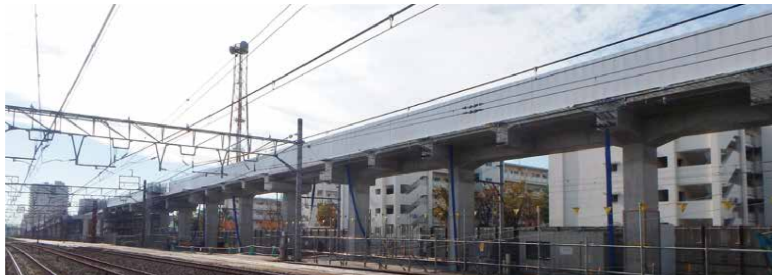
西新井～竹ノ塚間(栗六陸橋～UR竹の塚第二団地付近)高架橋工事進捗状況
