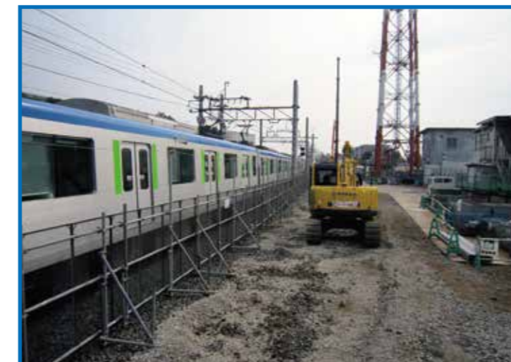
⑤ 野田市駅付近 高架橋建設工事
