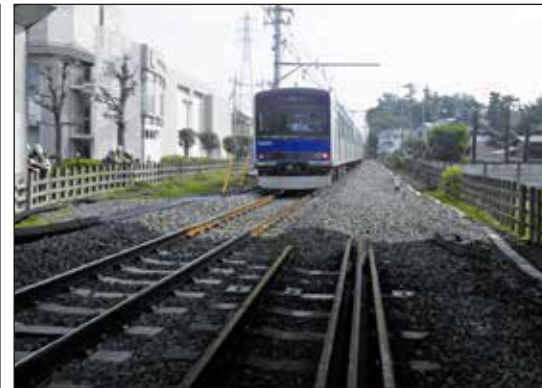
④ 9月28日から、梅郷方も現在線から仮線へ切り替えました。今後は現在線を撤去し、高架橋を建設していきます。
