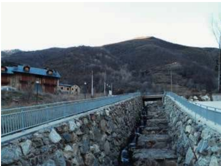
Figura 20. Infraestructura hidráulica en el sector de Els Estrellaus en el barranc d'Escobet, Espui, Vall Fosca.
