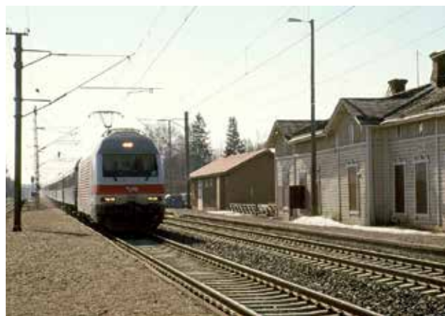
Viialan vanha asemarakennus vuonna 1998. Kuva: Juha Kutvonen
