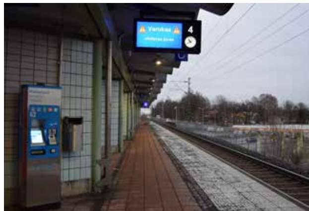
Pukinmäen aseman laiturilla on 1996 aallonmuotoisen katoksen, joka ylettyy melkein koko laiturin päästä päähän. Kuvat: Sonja Leppänen
