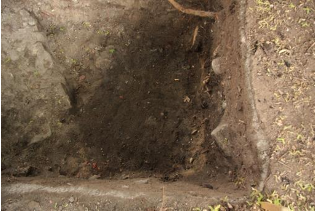
Kuva 11. Nokinen palokerros M008A rakennusjäännöksen R001 sisällä koilliseen. Kuvassa vasemmalla näkyy rakennuksen seinää R001A. Kuva AVAN2:1:120. Ilari Aalto/Aboa Vetus & Ars Nova.
