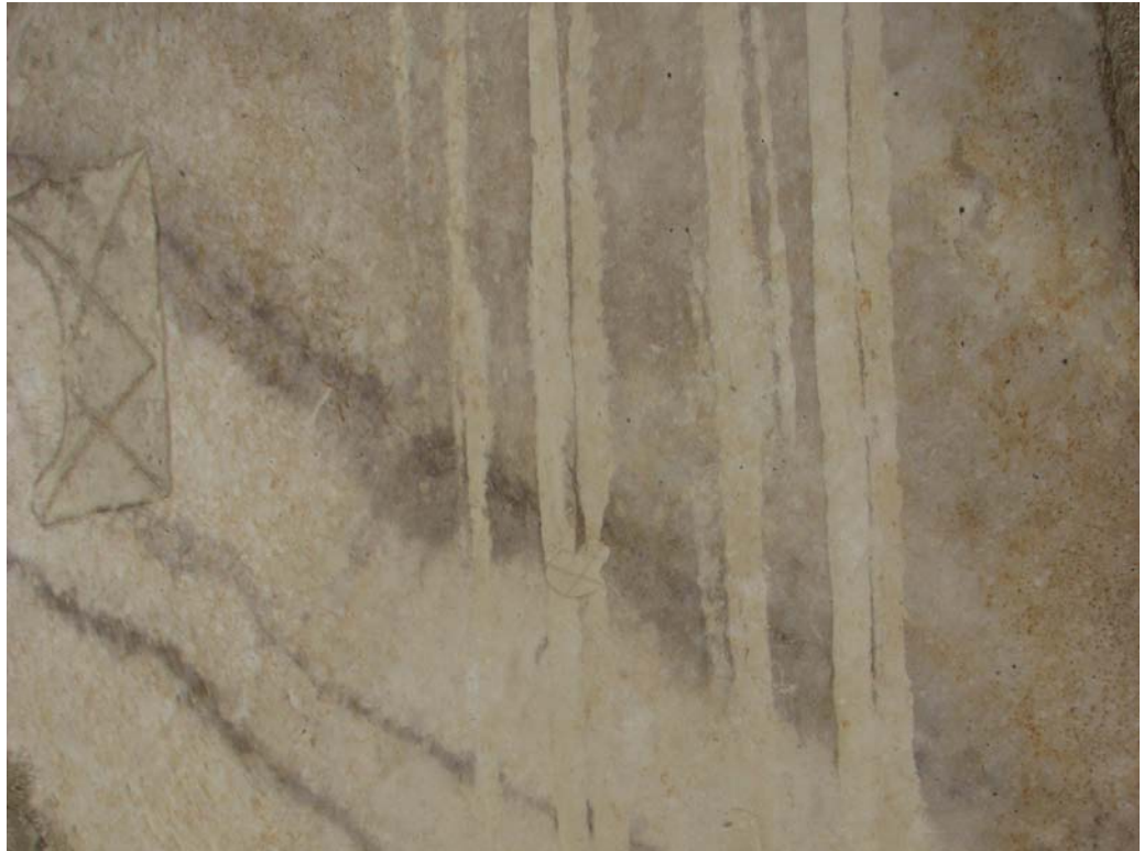
Afb. 7.68 Foto vanuit de bak van de kraan recht naar beneden.
