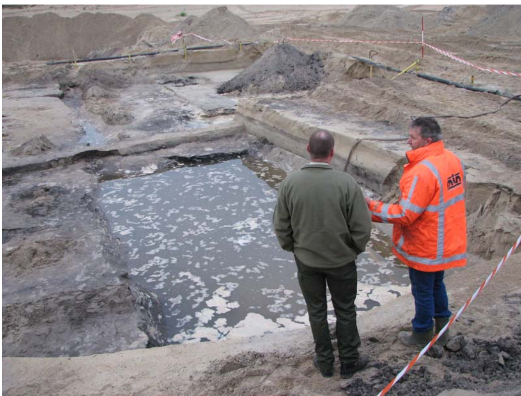
Afb. 7.13 Zonder bronbemaling zou de gehele werkput onderlopen. Hier bij het afwerken van plattegrond 3 was de bronbemaling in het weekend uitgevallen. Gelukkig was het merendeel al gedocumenteerd.
