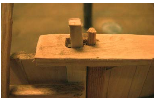
Afb. 15.16 De deur naar het woongedeelte kan alleen naar binnen toe open. De deurpost werd afgedekt met een balk.
