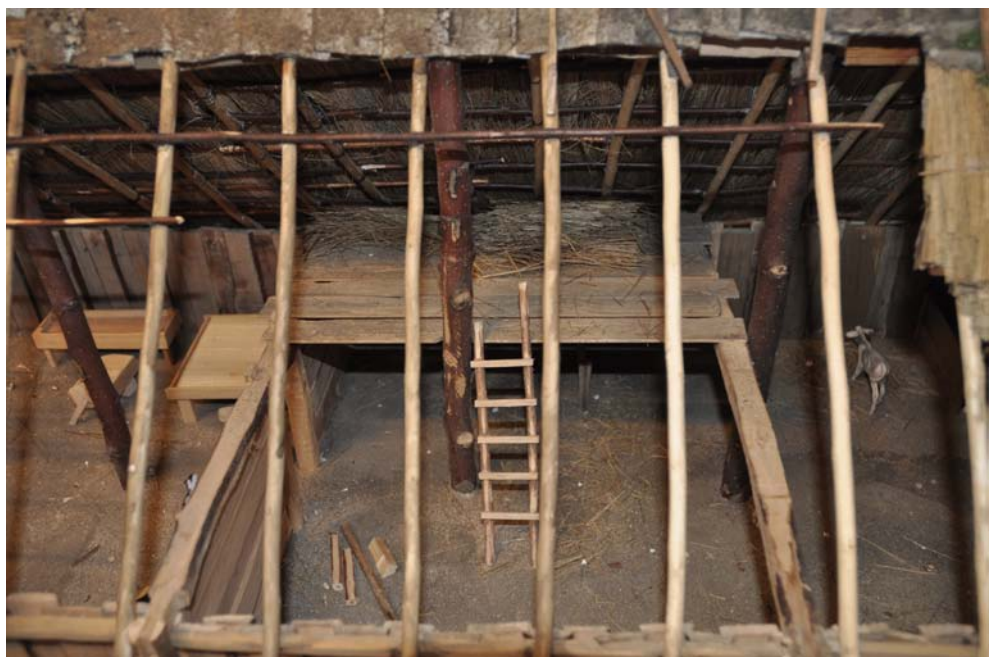
Afb. 15.26. Inkijkje vanuit het opengewerkte dak in het stalgedeelte. Vanwege een enkele extra buitenpaal is er voor gekozen een liggende balk te plaatsen met daarop een verhoogde vloer. Dergelijke verhogingen waren bij uitstek geschikt om allerlei zaken droog op te slaan.
