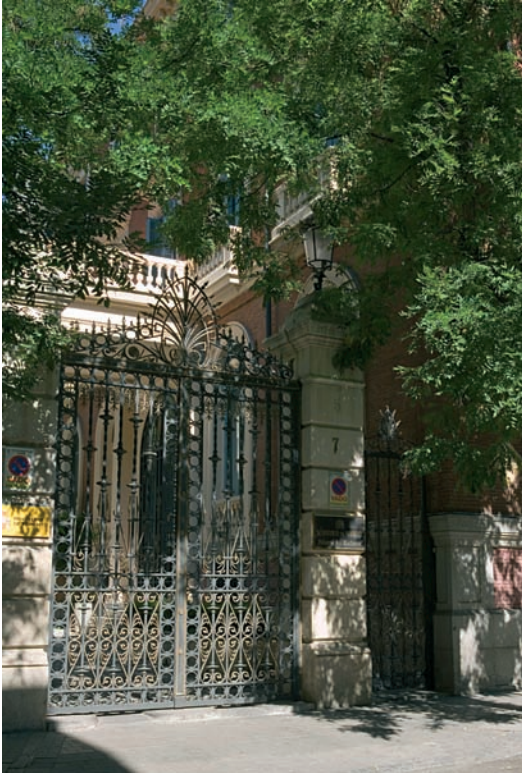
Puerta de acceso para vehículos.
