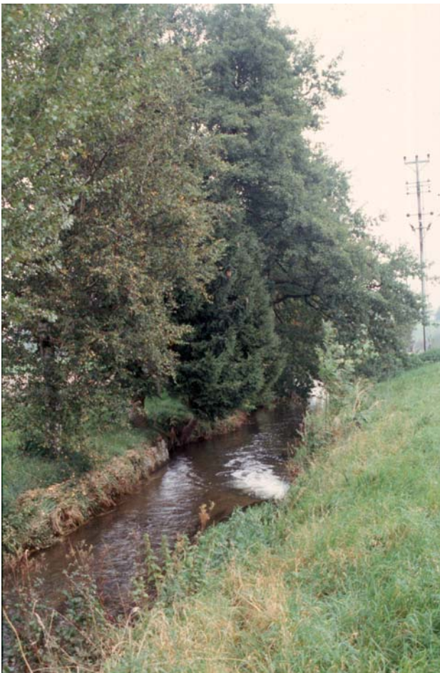
Urtenenstrecke im Bereich der ARA-Einleitung.
