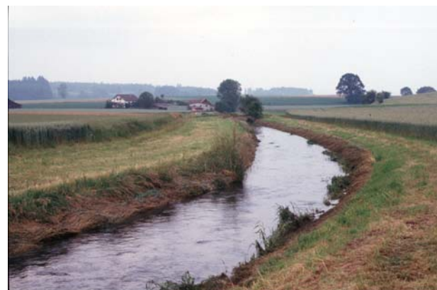
Unterhalb der ARA Holzmühle verläuft die Urtenen grösstenteils offen ohne höhere Vegetation. Die Böschungen sind auf weite Strecken mit Brettern und Längshölzern verbaut. Die Ufervegetation wird mit Mäher und Schlegel gemäht
