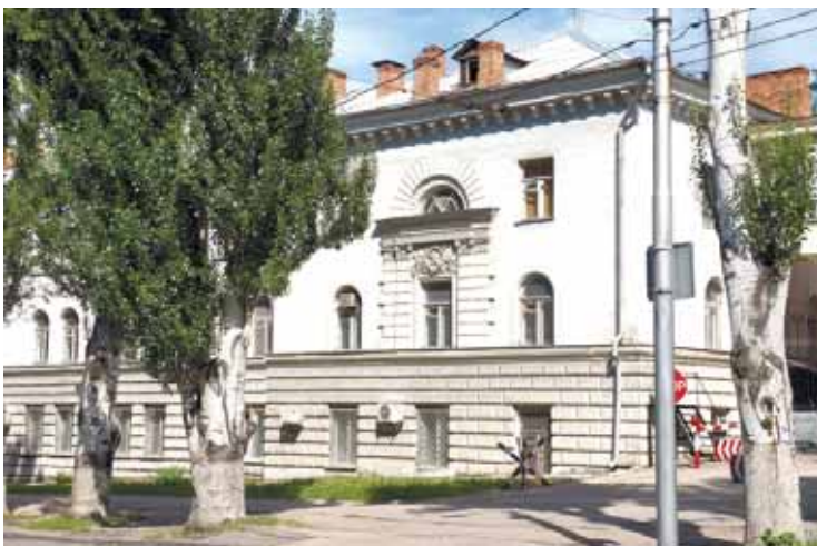
Архитектор В.П. Мелик-Парсаданов, ул. Гоголя, 37, административное здание ЧФ, первоначально казарма
