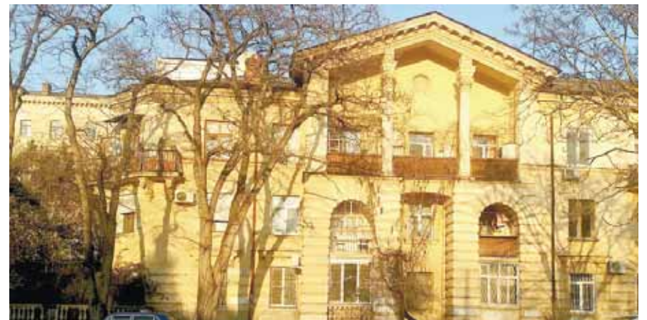
Архитектор В.П. Мелик-Парсаданов, ул. Одесская, д. 25
