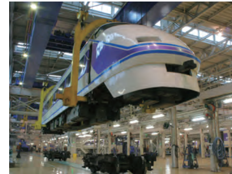
南栗橋車両管区工場棟車体作業場
