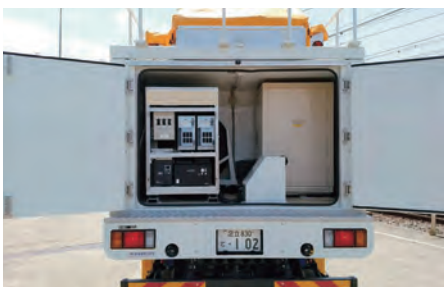
電気検測車に搭載された機器
