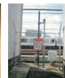
侵入防止フェンス
