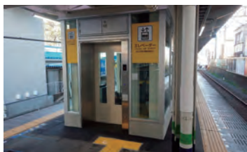
エレベーター
